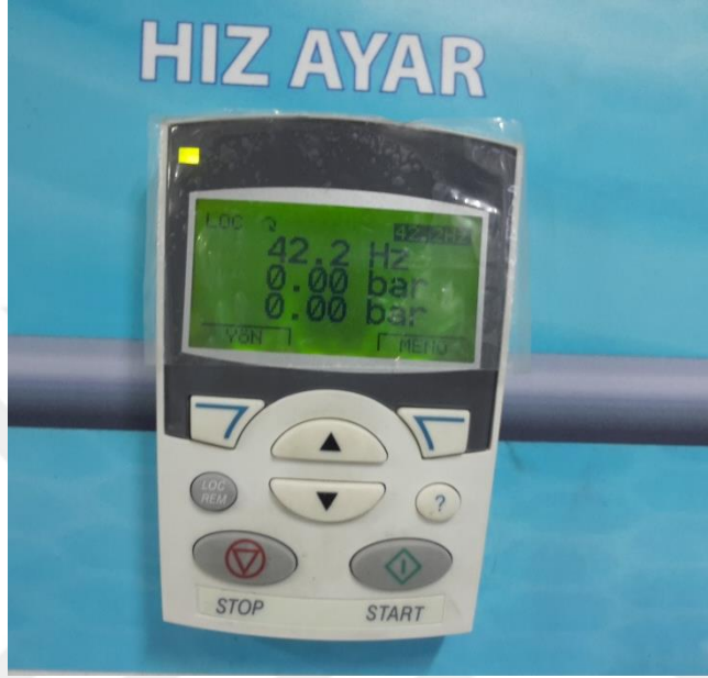
Şekil 6.8 : Pompa devir hızının ayarı.
