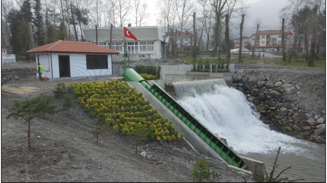
Şekil 3.38. Arşimet burgu türbin montajlı görseli
