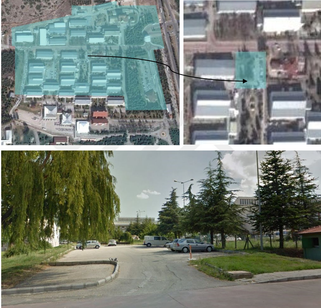
Şekil 4.28. III. Bölge – Yapı Laboratuvarı ve çevre binaları otoparkları (Orj., 2018)
