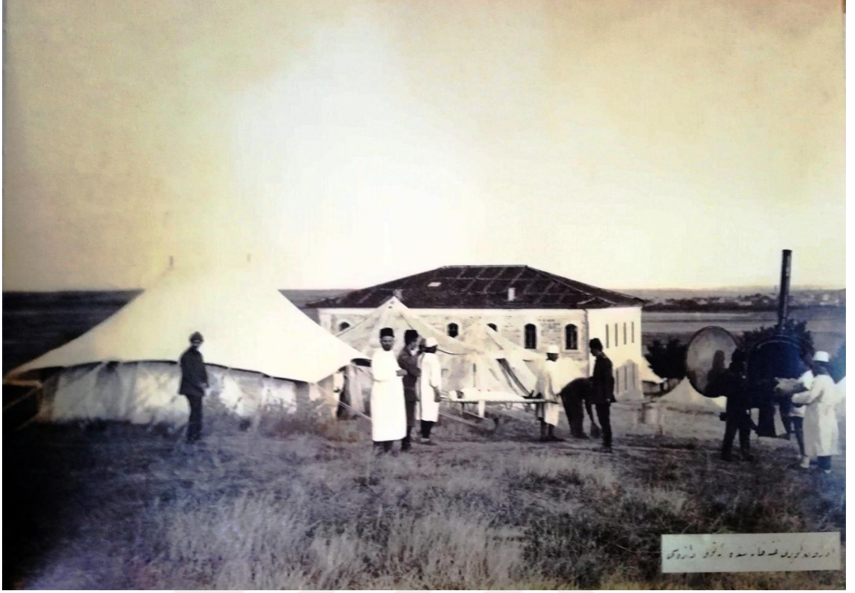
Fotoğraf-13: Uzunköprü Hastanesi'nde Etüv Dairesi.
