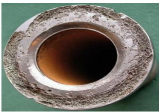
Resim 5.1. Malzeme yüzeyindeki aralık korozyonu görüntüsü
