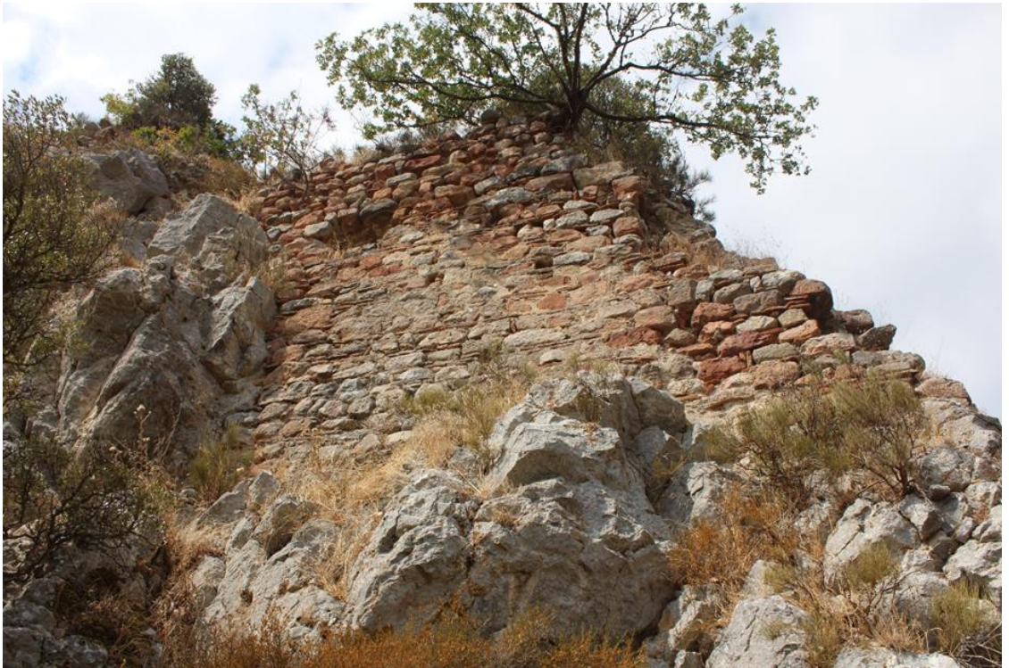
Resim 11: Bizans Kalesi Duvar Yapı Tekniği (Gömeniç)
