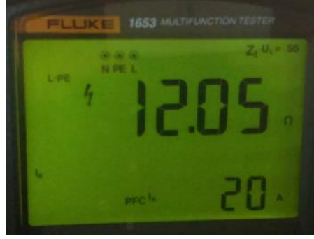
Şekil 5.15: L-PE çevrim empedansı ölçüm sonucu
