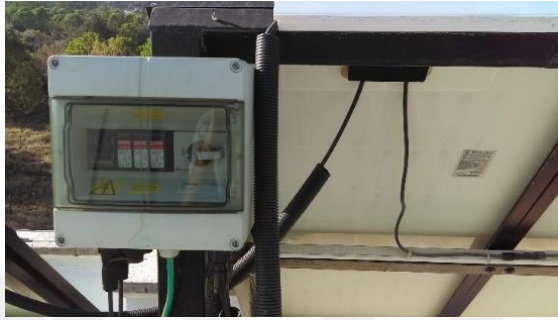
Şekil 4.5: FV panel grubu çıkışındaki SPD kutusu
