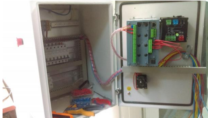
Şekil 5.2: FV santral şebeke entegrasyon panosu iç donanımı
