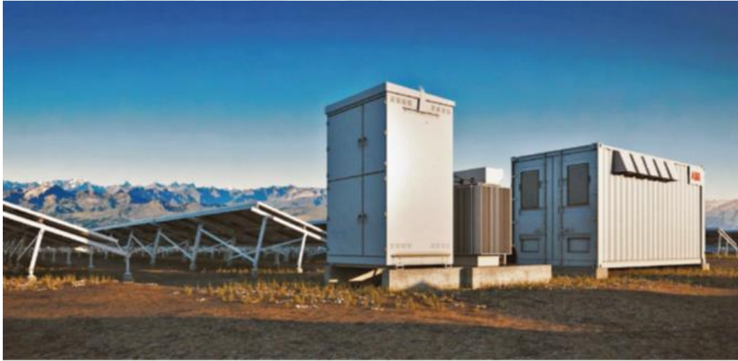
Şekil 3.11: Merkezi evirici (ABB, 2018 a )
