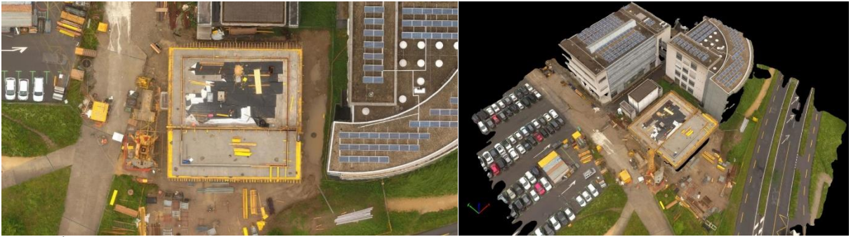
Lozan – İsviçre’de bir inşaat sahası. Tarih: 25.08.2016
