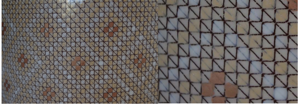
Resim 194- Uygulama 21, çalışmanın farklı açılardan görünümü
