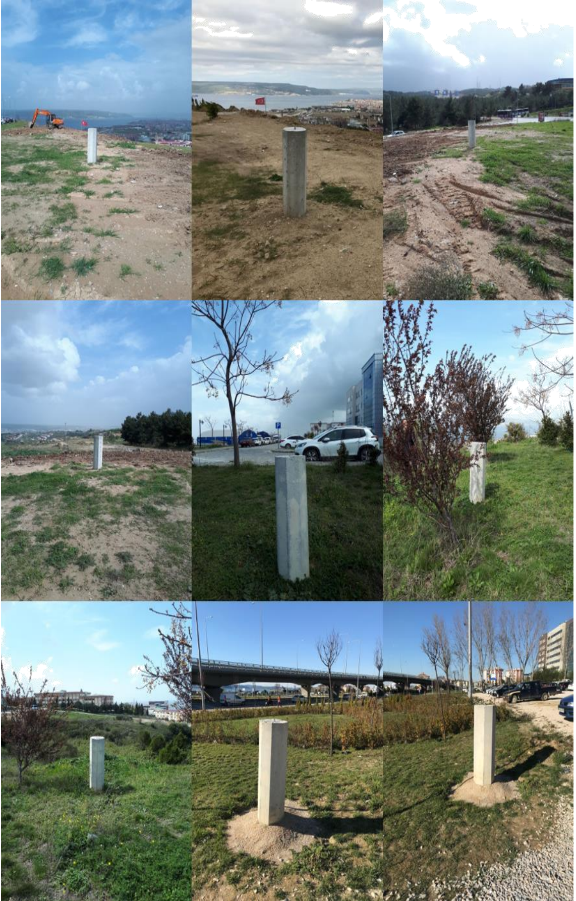
Şekil 4.25. ÇOMÜ Terzioğlu Yerleşkesinde tesis edilmiş pilyelerden örnekler
