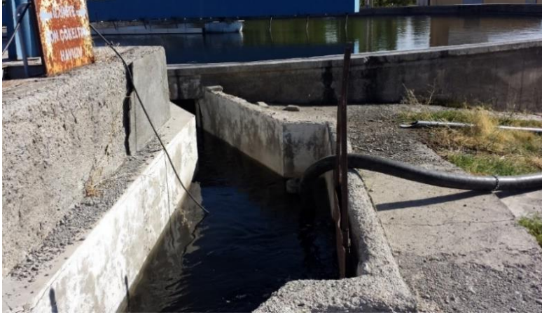
Şekil 3.6. Van İskele Atık Su Arıtma Tesisi çıkış suyu
