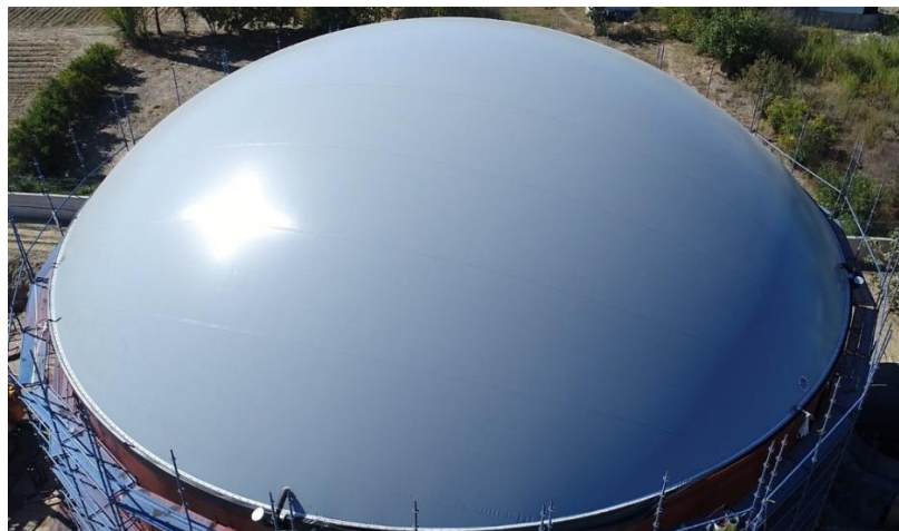
Şekil 4.2. Membran tip biyogaz tesisinde kullanılan membran (balon) (URL-7).
