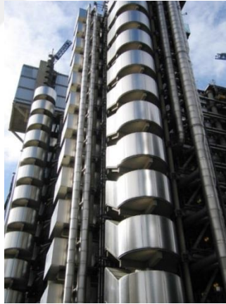
Şekil.3.20. Lloyds Binası-Cephedeki Servis Birimleri
