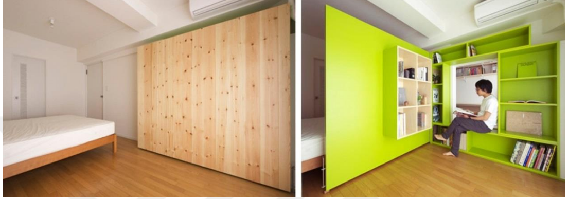
Şekil 3.59. Bir Eksen Etrafında Belirli Açı ile (90 derece) Dönebilen Tam Bölücü Örneği
