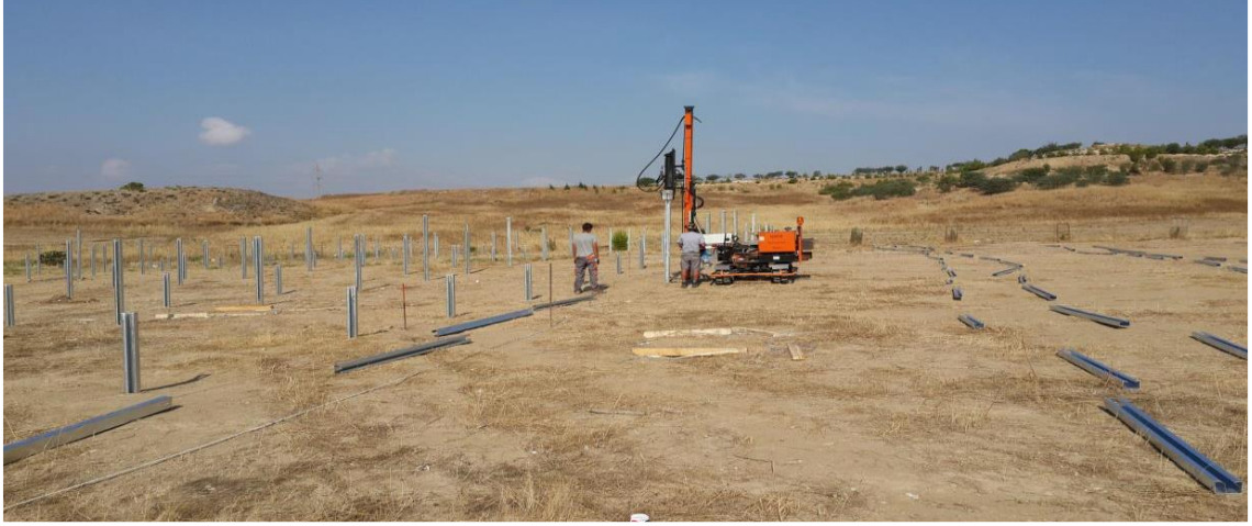
Şekil 3.17. Taşıyıcı ayakların montajı [53]
