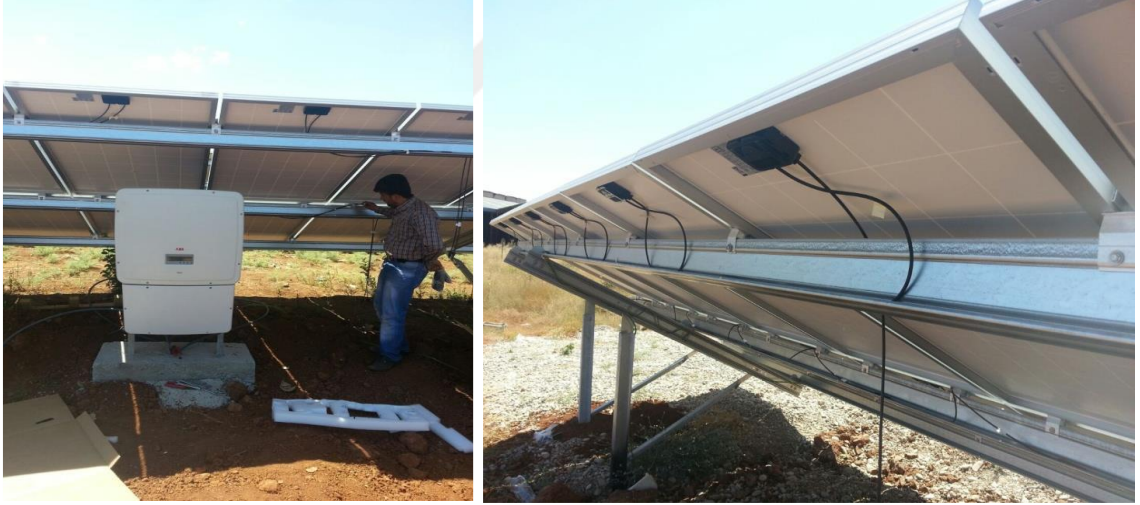
Şekil 3.20. İnverter Montajı Aşaması [53]
