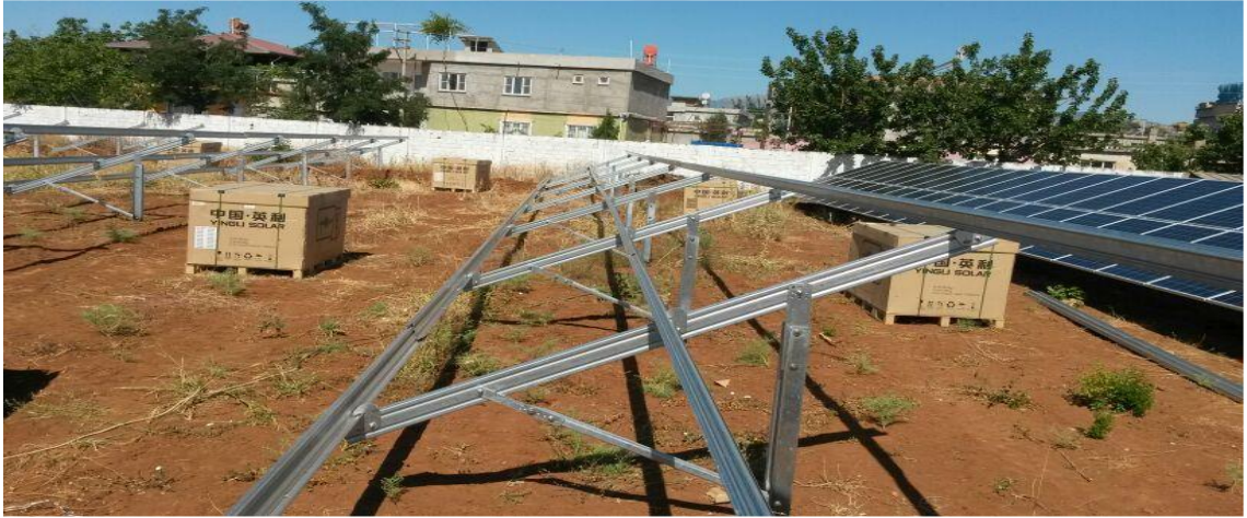
Şekil 3.18. Metal Konstrüksiyon Aşaması [53]
