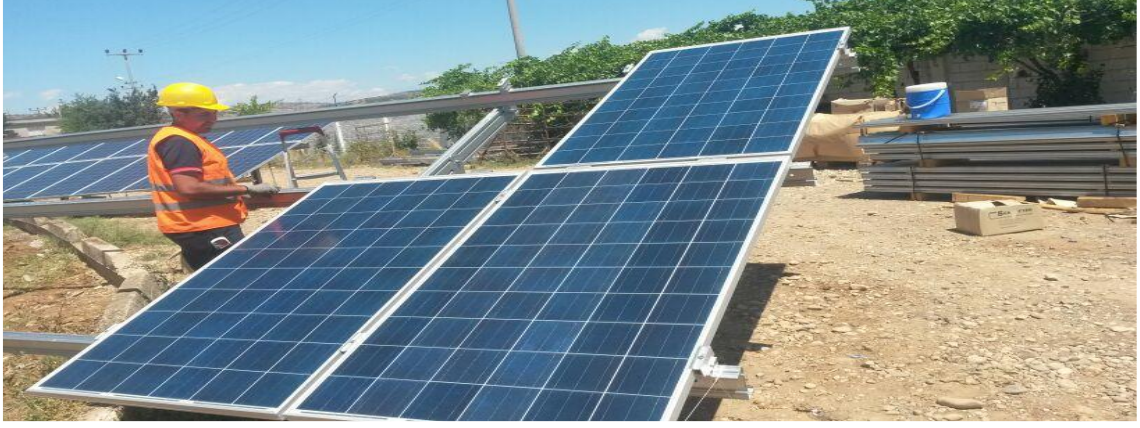
Şekil 3.19. Panel Montajı Aşaması [53]
