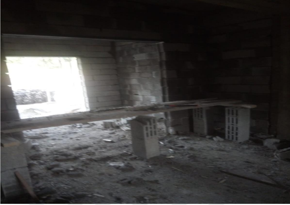
Resim 9: Şantiye sahası içerisinde bulunan bir daireden kare.
