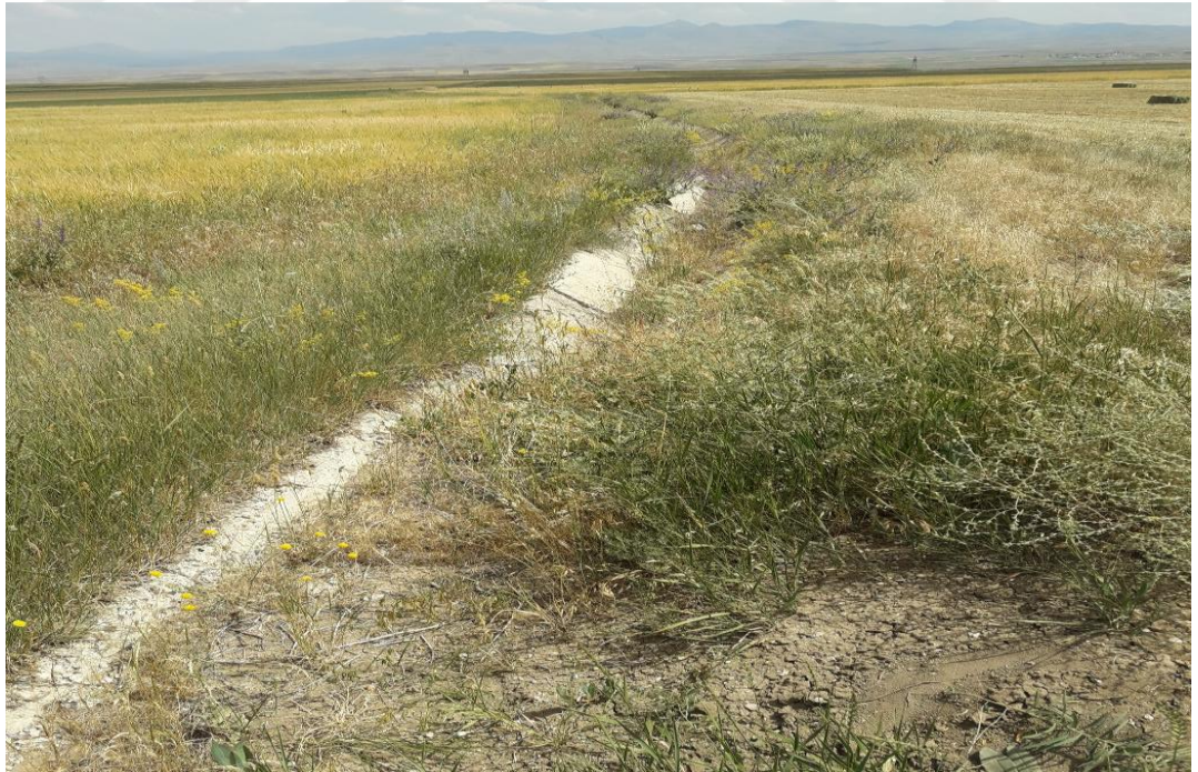
Şekil 4.10. Kanalların siltasyon ve otlanma ile doluluğunu gösteren örnek görüntü
