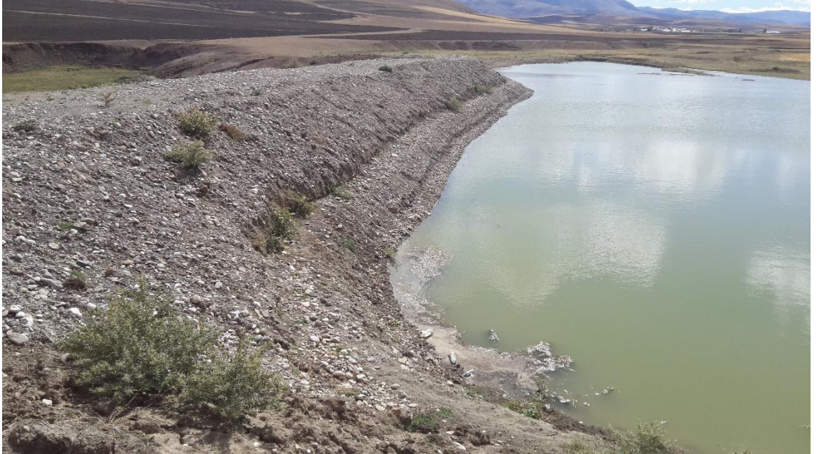
Şekil 4.19. Çamurlu mahallesi hayvan içme suyu göleti
