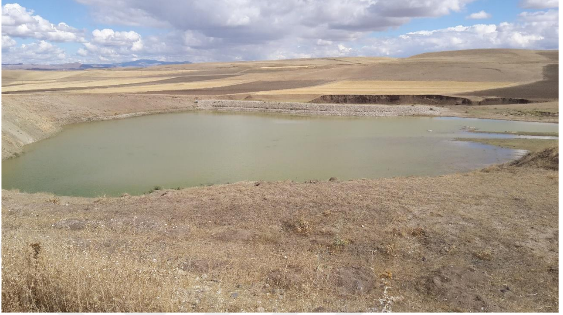
Şekil 3.7. Çamurlu mahallesi hayvan içme suyu göleti genel görünümü
