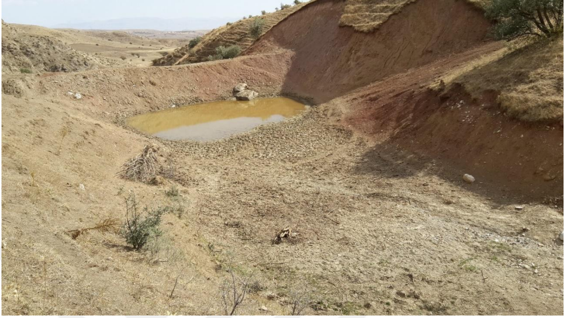
Şekil 3.5. Hacıahmet mahallesi hayvan içme suyu göleti (2) genel görünümü
