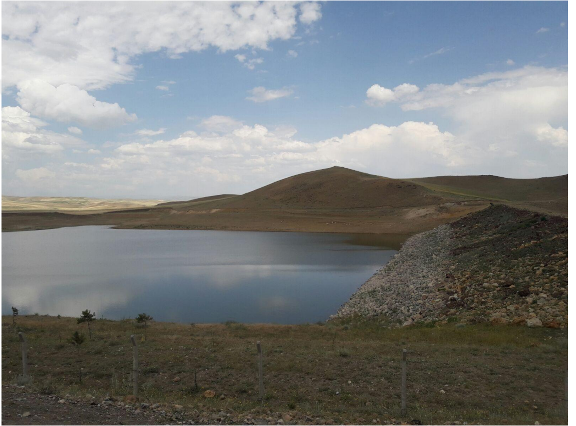
Şekil 3.3. Aşağı kızılca mahallesi sulama göleti genel görünümü
