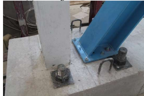
(d) Completed mounting of steel columns
