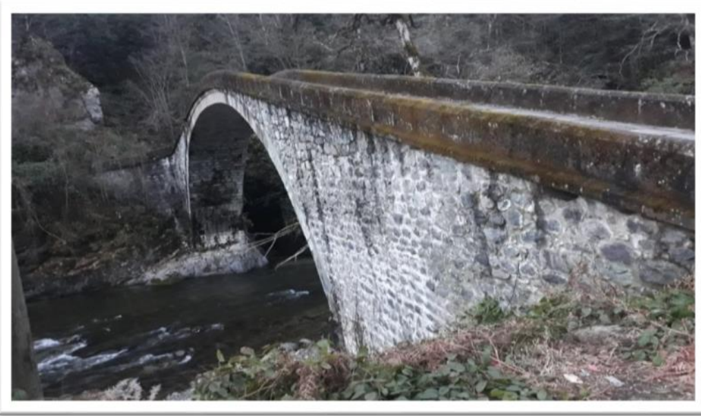
Şekil 37. Tarihi taş kemer köprüden bir görünüm, Çakmakçı, İ. (2018).
