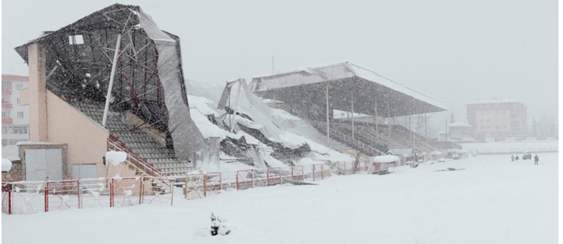
Şekil 1.1. Bilecik Edebalı Stadı çatısının çökmesi(URL-1).
