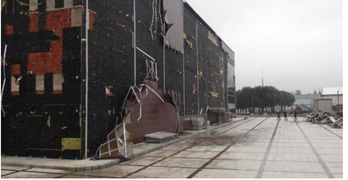
Şekil 1.3. Bursa’da Afet Eğitim Merkezi dış cephe kaplaması sökülmesi(URL-3).
