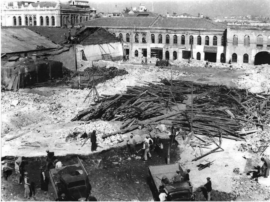
Şekil 4.8 : Topçu Kışlası'nın yıkımı (Url-5, 1940).
