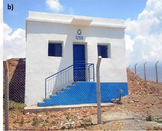
b) Gaziosman Paşa köyünde yeni su deposu
