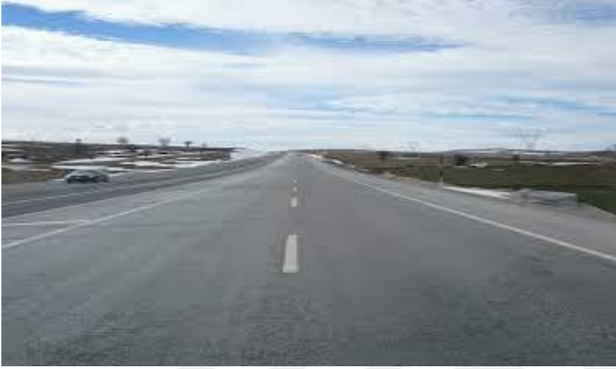
Foto 15: Çerçi köyü dolaylarında D 180 karayolundan bir görünüm
