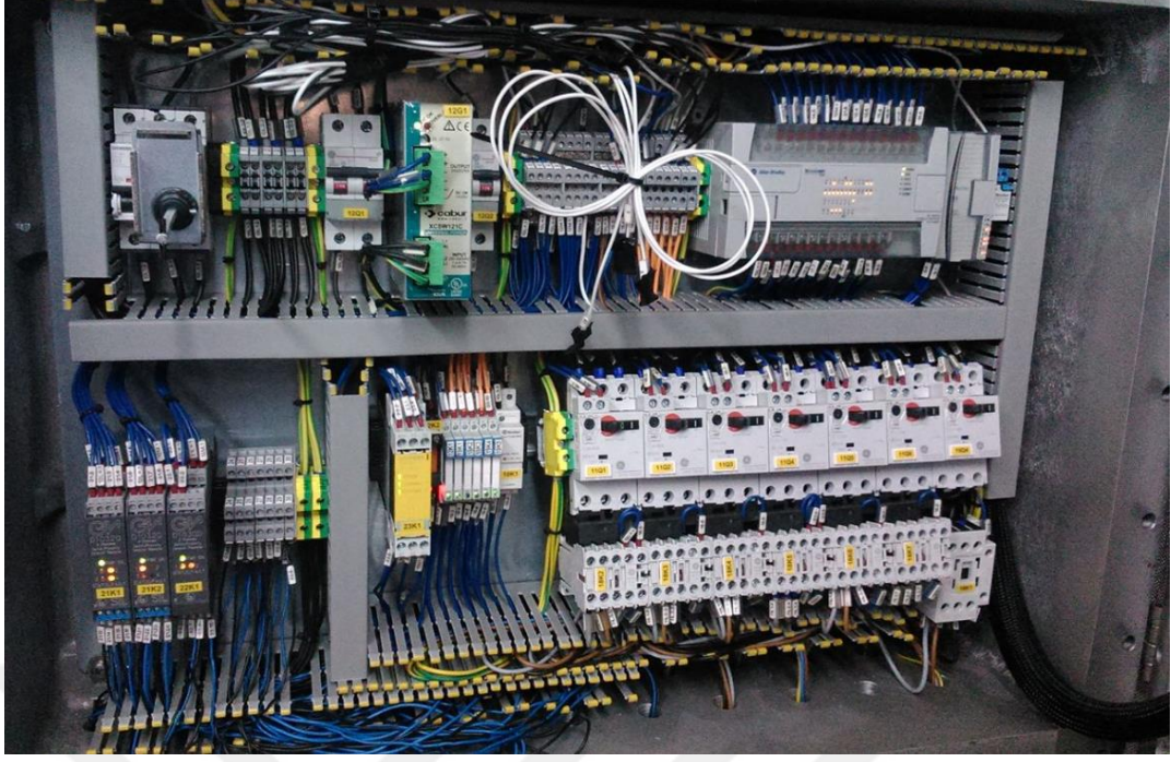
Şekil 2. 7 Bir abkant presin elektrik panosu [23]
