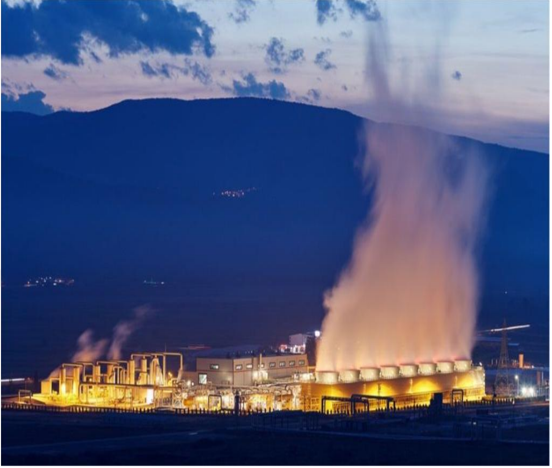
Şekil 3.4. Flaş tip buhar ile elektrik üretimi Alaşehir jeotermal santrali
