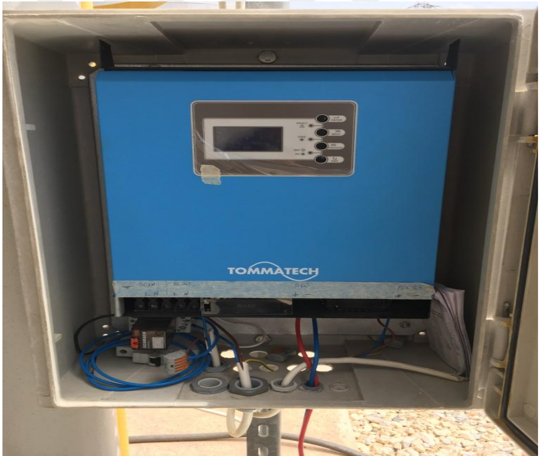
Şekil 6.10. Tam sinüs inverter
