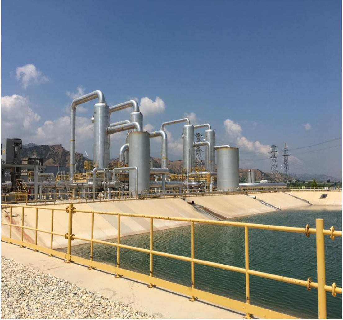
Şekil 6.3. Flash tip jeotermal santrali buhar ayırıştırma seperatörü
