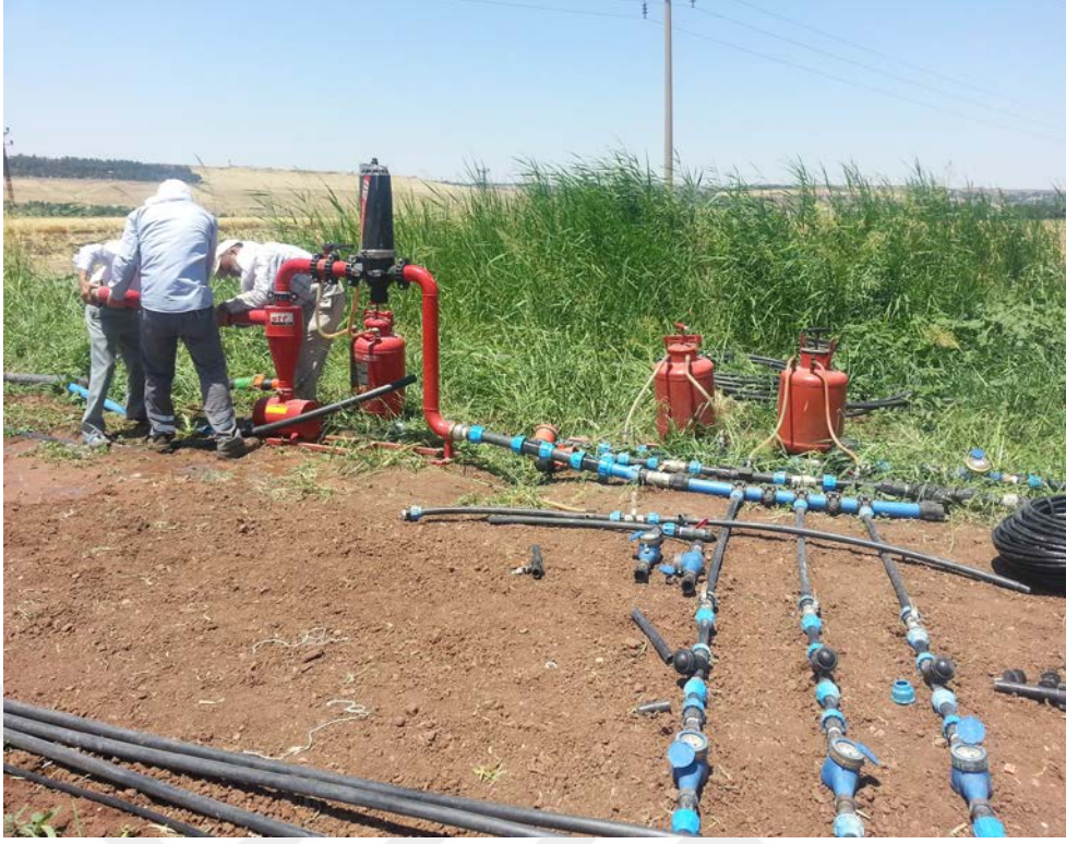
Şekil 3.7. Damla sulama sisteminin kurulumu
