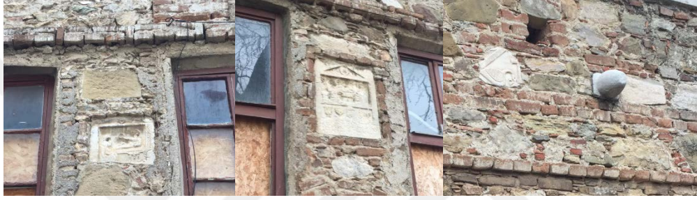
Şekil 3.34 Kilise’de kullanılan devşirme malzemeler (M.D. – 2018)
