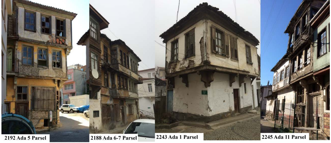
Şekil 4.6 Kullanılmayan bakımsız yapılar (M.D.-2018)
