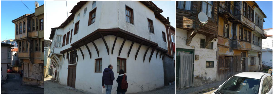
Şekil 3.65 Çalışma alanındaki konutların zemin kat cephe özellikleri (M.D. – 2018)
