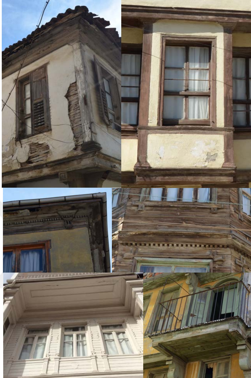
Şekil 3.67 Çalışma alanındaki çıkma köşelerinde ahşap sütunlar, saçak altı silme ve çıkma altı kare motifli ahşap kaplama örnekleri (M.D. – 2018)
