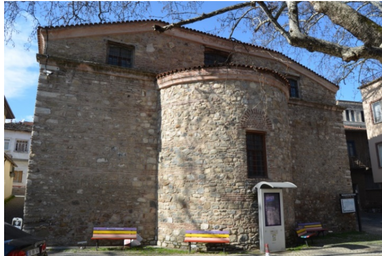
Şekil 3.35 Yapının günümüzdeki hali ( M.D. – 2018 )
