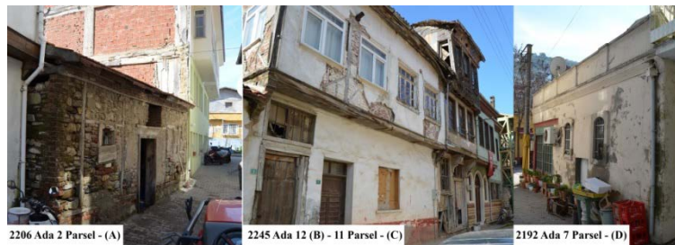
Şekil 3.103 Çalışma alanında yığma yapı ve ahşap karkas örnekleri (M.D. – 2018)
