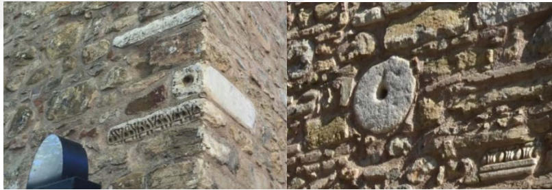
Şekil 3.39 Yapıda kullanılan mermer devşirme malzemeler (M.D. – 2018 )
