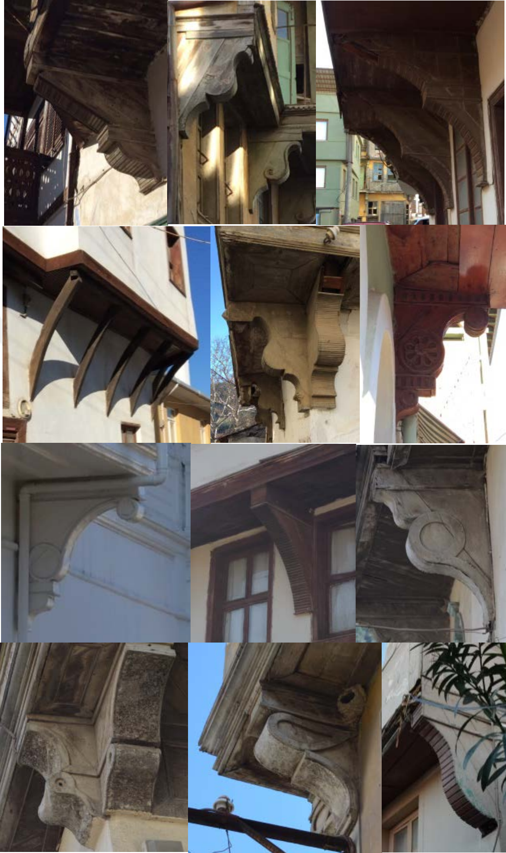
Şekil 3.66 Çalışma alanındaki konutlarda ahşap payandalar (M.D. – 2018)
