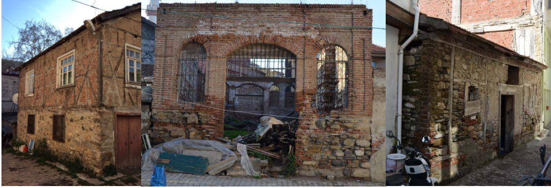
Şekil 3.62 Çalışma alanında bulunan geleneksel konutların zemin katlarında ya da tamamında taş, tuğla veya taş-tuğla almalı örülerek yığma kâgir sistemle inşa edilmiş yapı örnekleri (M.D. – 2018)
