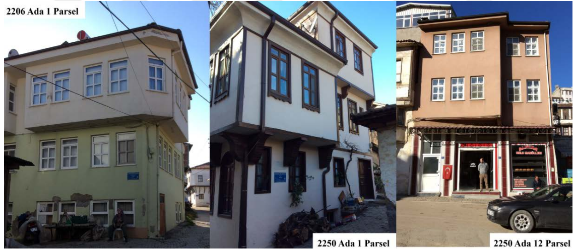
Şekil 4.5 Geleneksel yapıların yerine yapılan yeni yapılar (M.D.-2018)
