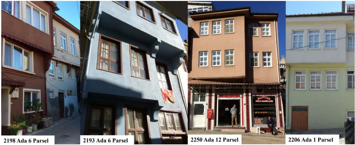
Şekil 3.73 Çalışma alanında bulunan geleneksel konutların zaman içinde değişikliğe uğramış pencere örnekleri (M.D. – 2018)
