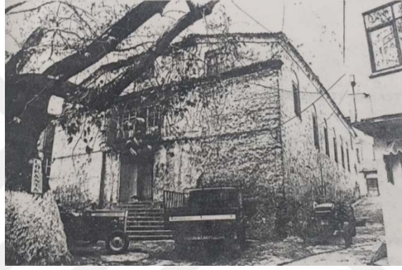
Şekil 3.36 Kilisenin apsis kısmının yıkılarak giriş kapısı konuldu (Abanozoğlu, 1987)
