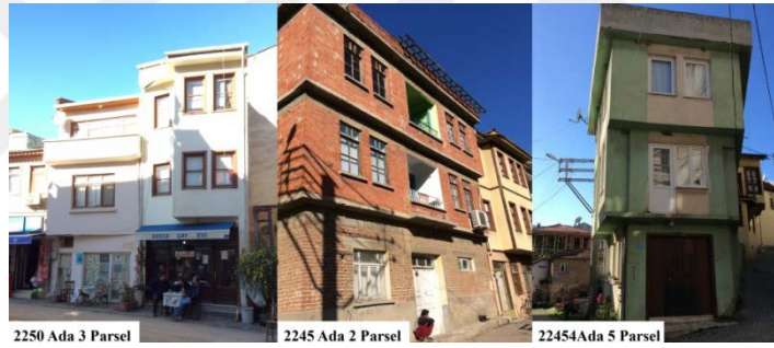
Şekil 3.102 Çalışma alanındaki betonarme yapılar (M.D. – 2018)
