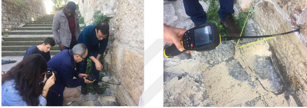
Şekil 3.10 Avlu duvarları üzerinde endoskopik muayene çalışmaları (Kişisel arşiv, 2018)
