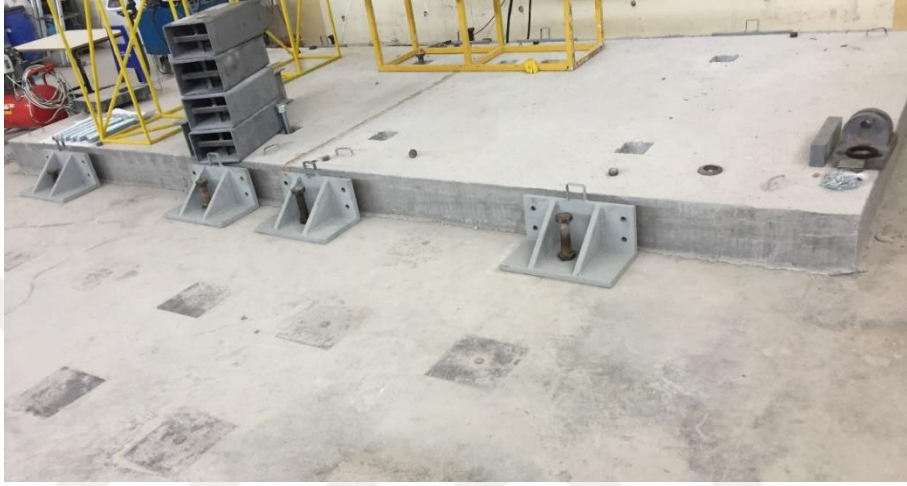
Şekil 3.23 Betonarme yastığın stoper ve saplamalarla sabitlenmesi (Kişisel arşiv, 2018)
