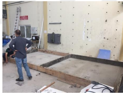
(a) Kalıpların yerleştirilmesi
