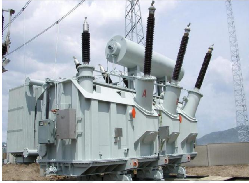
Şekil 3.3. Güç transformatörü
