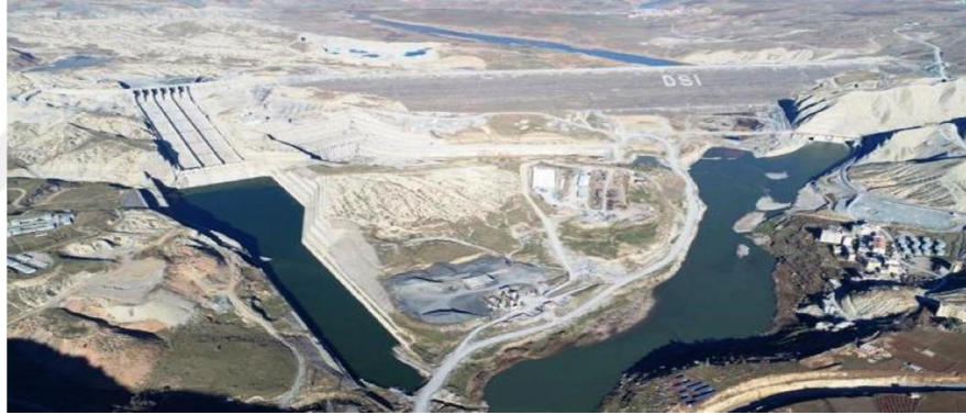
Şekil 2. 18 Ilısu Barajı ve HES [43]
