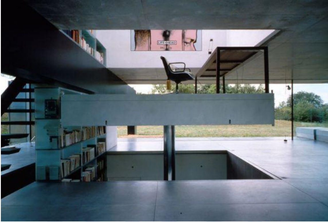
Şekil 3.25 Bordeaux Evinin hidrolik asansörü [76]
