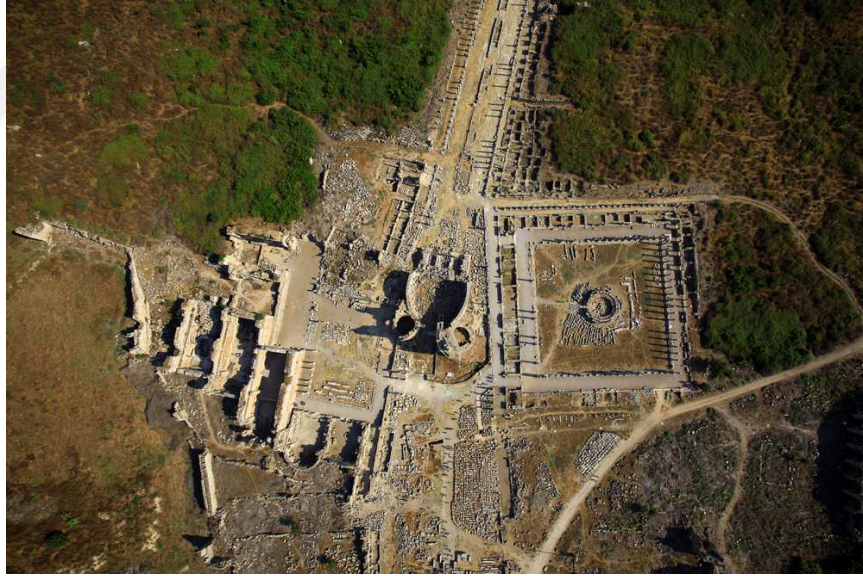
Şekil 5: Perge güney kent girişini gösteren hava fotoğrafı
