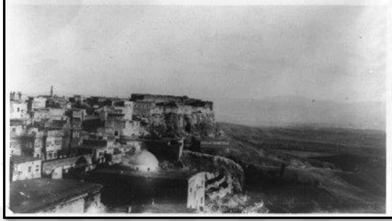
Şekil 4.26: 1900'lü yıllarda Kayabaşı Mahallesi (KUDEB, 2019).
