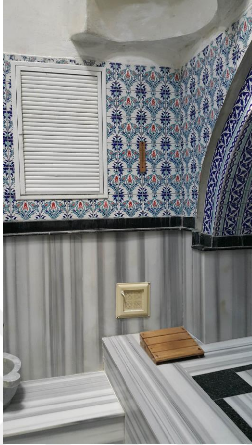
Şekil A.124 : Su deposuna açılan pencere kapağı.
