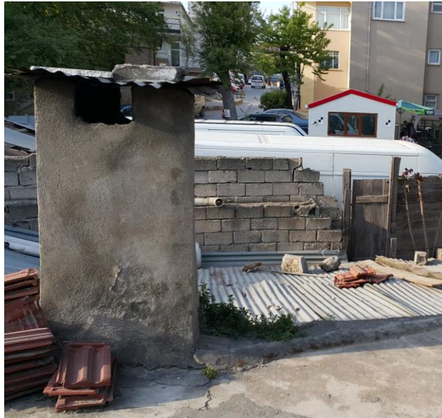
Şekil A.142 : Külhana ait duman bacası.
