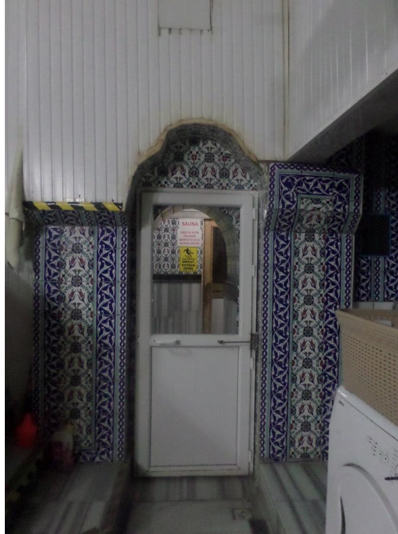
Şekil A.36 : Soyunmalık bölümünden ılıklığa geçiş kapısı.
