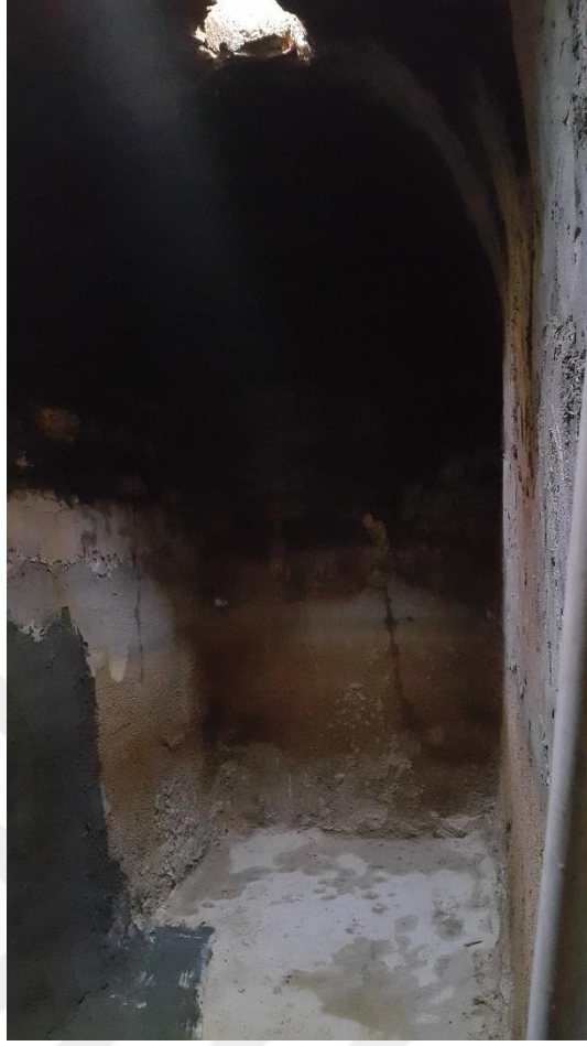
Şekil A.128 : Su deposu.
