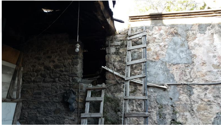
Şekil A.131 : Batı cephesindeki su motoru yeri.
