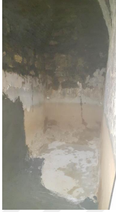
Şekil A.130 : Su deposundaki duvar sıvaları.
