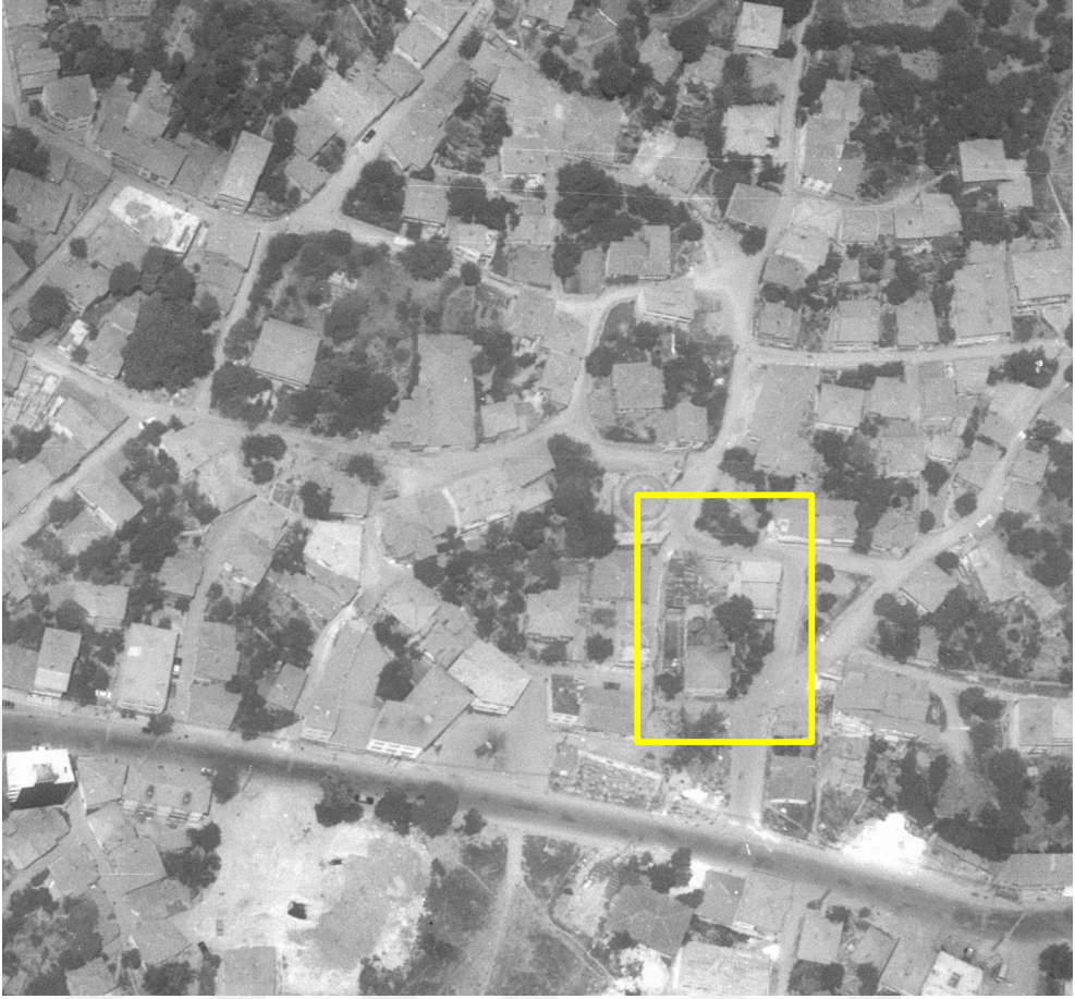
Şekil B.25 : Menzilhane Hamamı hava fotoğrafı (H.G.M., 1976).
