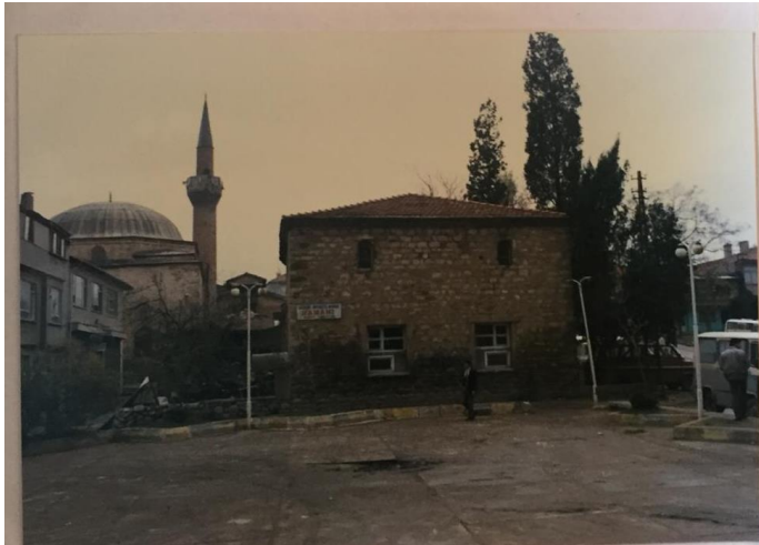
Şekil B.5 : Menzilhane Hamamı cephesi (K.K..V.K.K. Arşivi, 1990).
