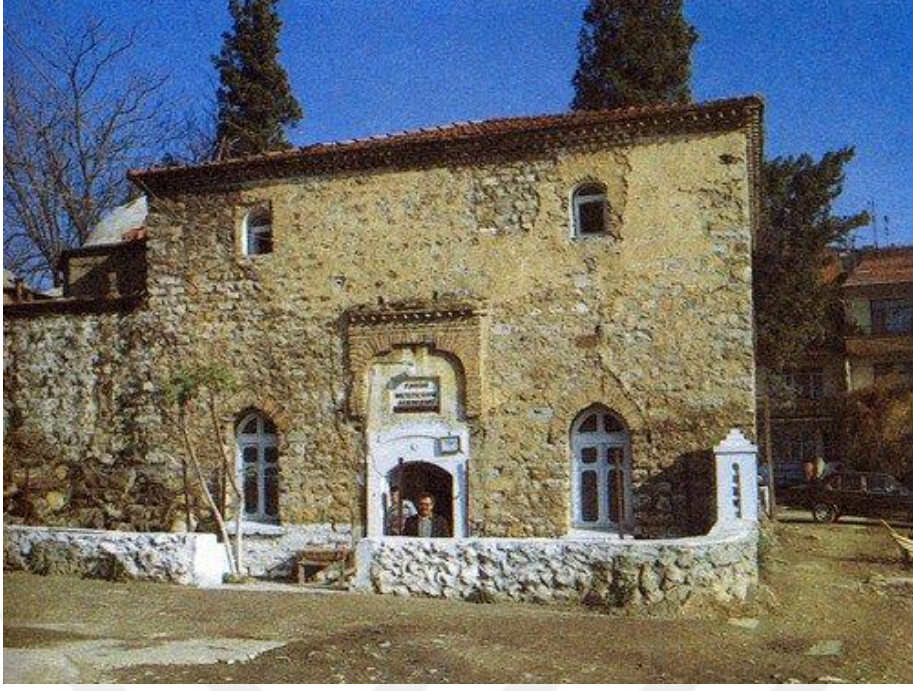
Şekil 4.16: Menzilhane Hamamı batı cephesi (Gebze Belediyesi Arşivi).
