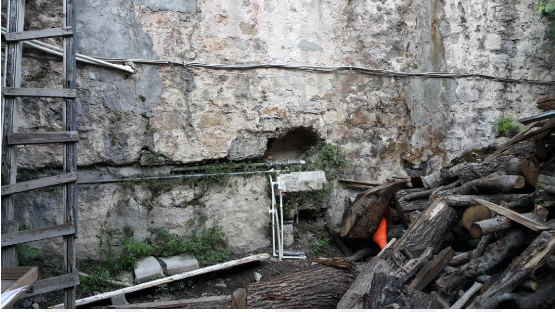
Şekil A.159 : Batı cephesine devşirme taş kullanılmış niş.
