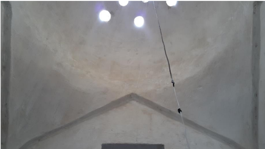
Şekil A.111 : Kubbe geçiş elemanları.
