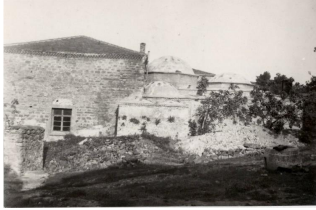
Şekil 3.11 : Menzilhane Hamamı doğu cephesi (Ülgen Arşivi) 1 (Url-10).
