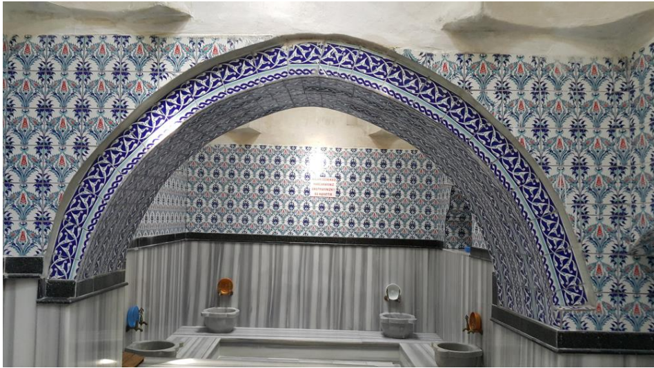
Şekil A.127 : Z15 hücreleri ayıran destekleyici kemer.
