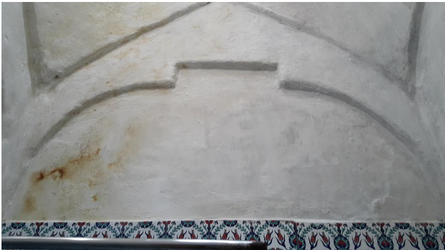
Şekil A.95 : Z11 güney duvarı kemerleri.
