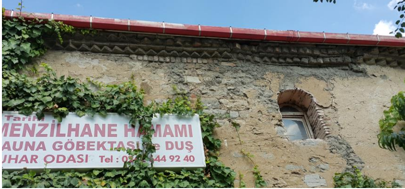
Şekil A.155 : Batı cephesi saçak korniş.
