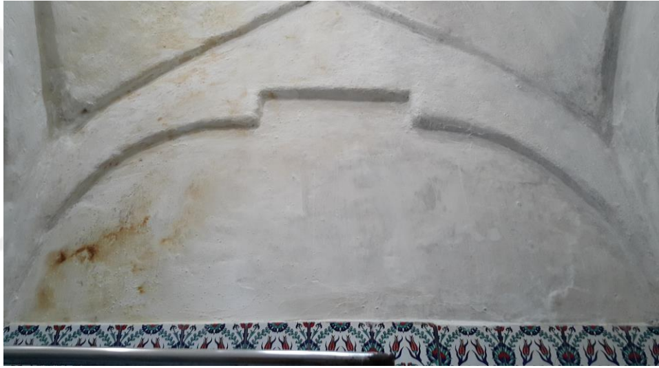
Şekil A.194 : Ilıklık ve sıcaklık mekânlarındaki sağır kemerler.
