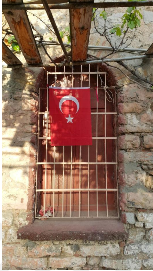
Şekil A.45 : Soyunmalık bölümü güney P1 penceresi.
