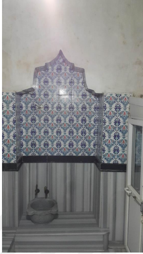
Şekil A.107 : Sıcaklık mekânı güney duvarındaki niş.
