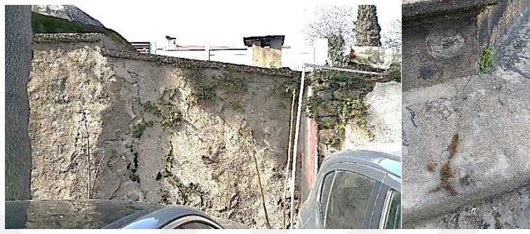
Şekil 3.17 : Bitkilerin neden olduğu mekanik bozulma.
