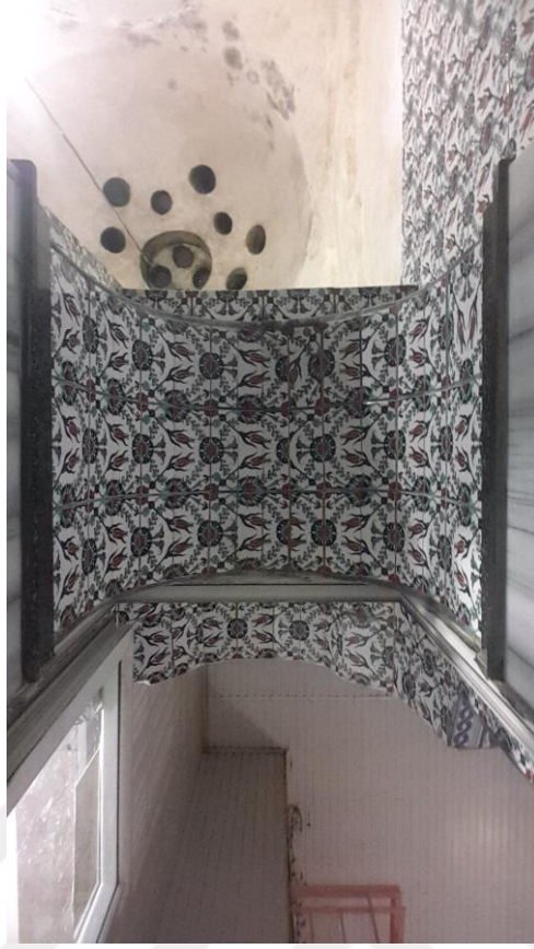
Şekil A.37 : Soyunmalık bölümünden ılıklığa geçiş kapısı.
