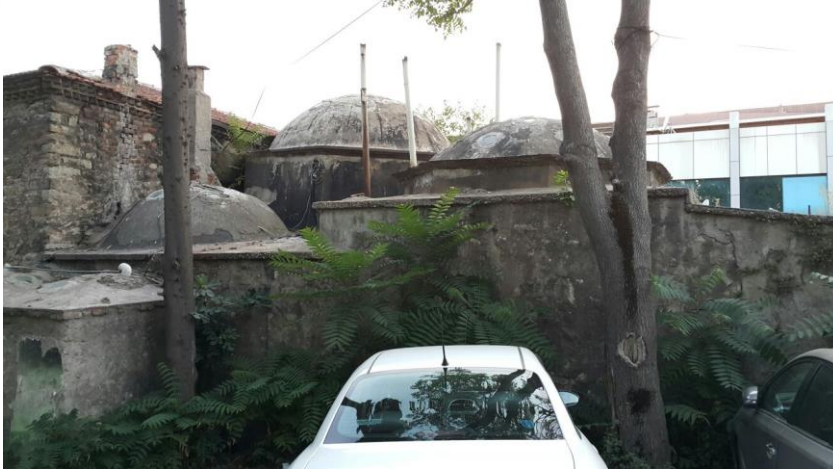
Şekil A.172 : Doğu cephesinde hacimlerin kademeli görünümü.
