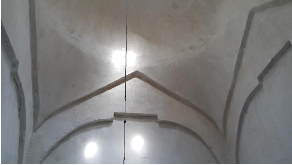
Şekil A.196 : Sıcaklık mekânındaki pendentifler.
