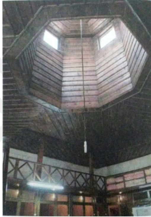
Şekil A.223 : Bursa Eski Orhan Hamamı (Şehitoğlu, 2008).
