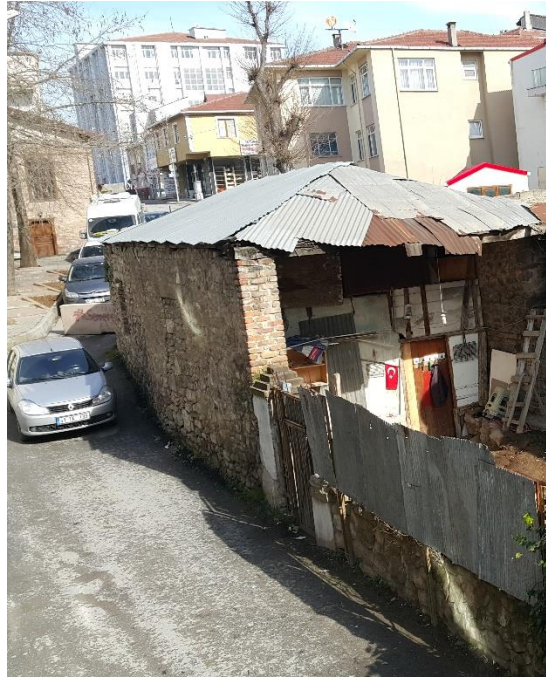
Şekil A.149 : Z19 müştemilat mekânı çatı örtüsü.
