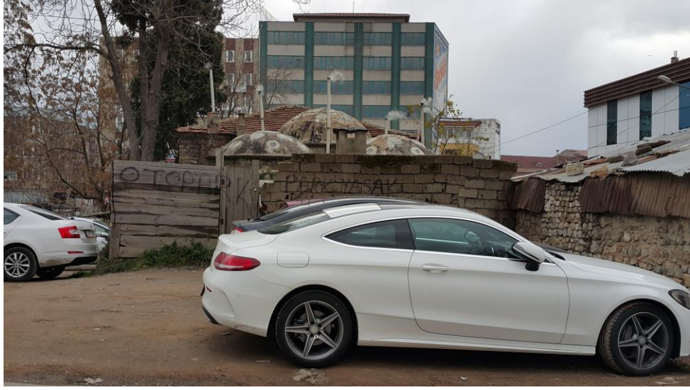
Şekil A.179 : Hamamın kuzey cephesi.
