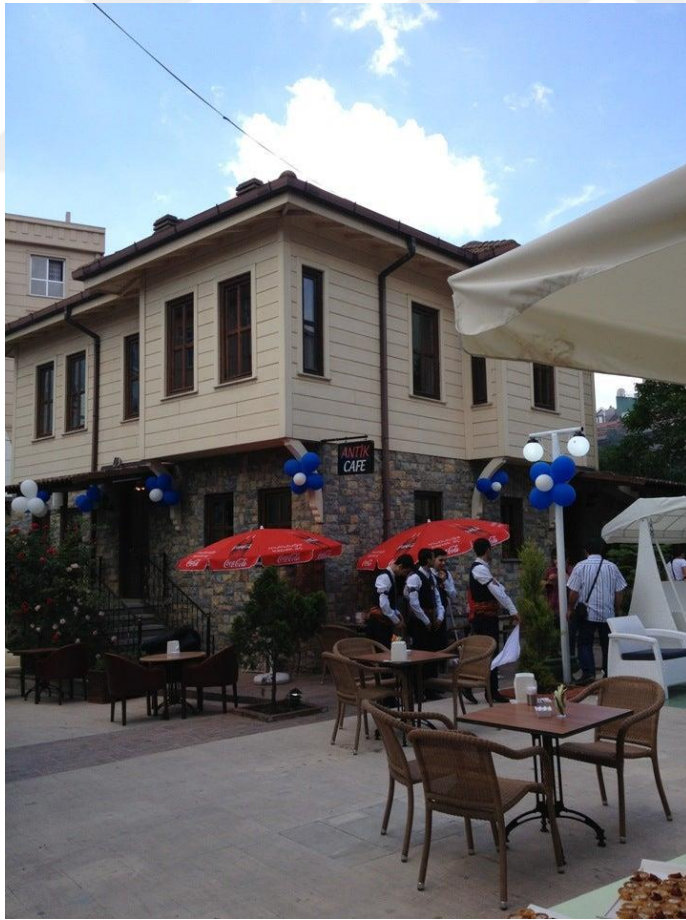
Şekil A.3 : Sit alanında sivil mimarlık örneği.
