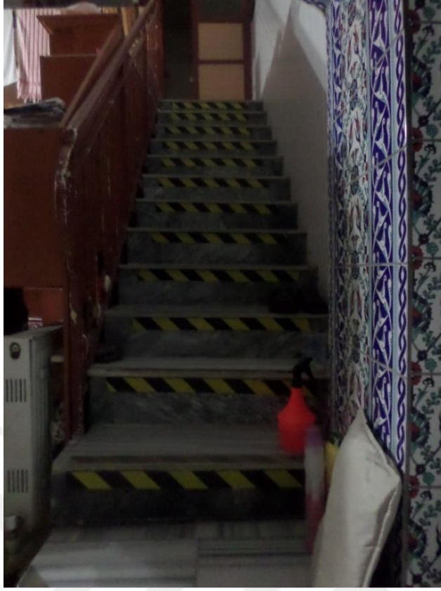
Şekil A.39 : Asma kata çıkan betonarme merdiven.
