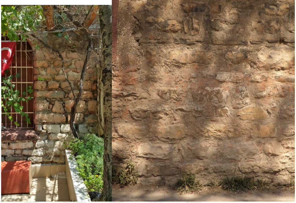
Şekil A.184 : Kireçtaşı malzeme ile moloz taş örgüsü.
