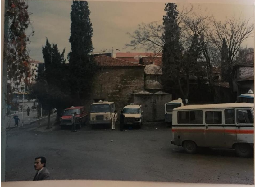
Şekil B.3 : Menzilhane Hamamı cephesi (K.K.V.K.K. Arşivi, 1990).
