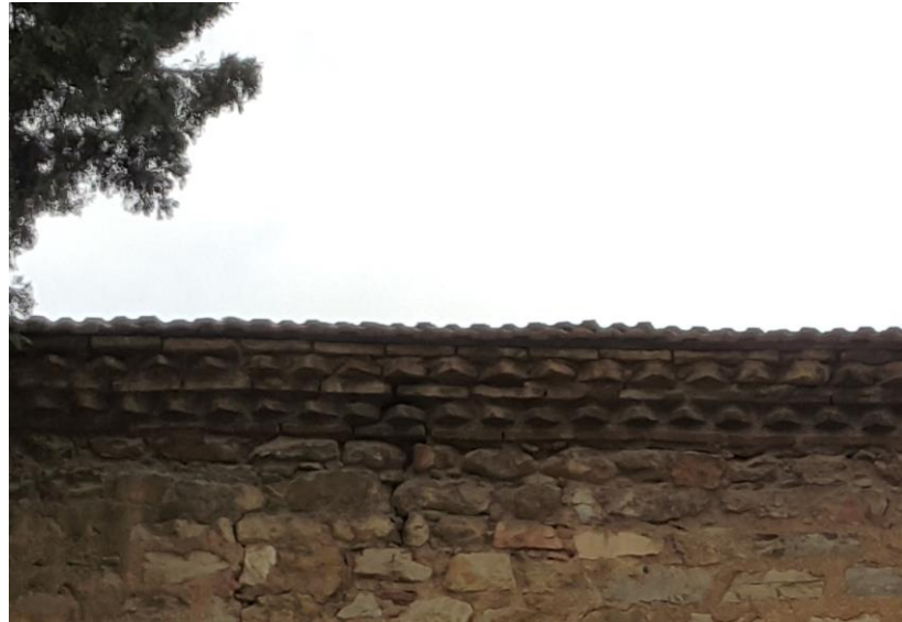
Şekil A.170 : Doğu cephesi saçak korniş.
