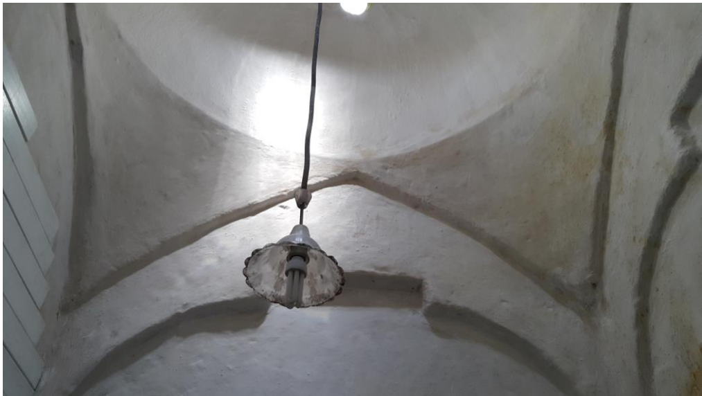
Şekil A.195 : Ilıklık mekânındaki pendentifler.
