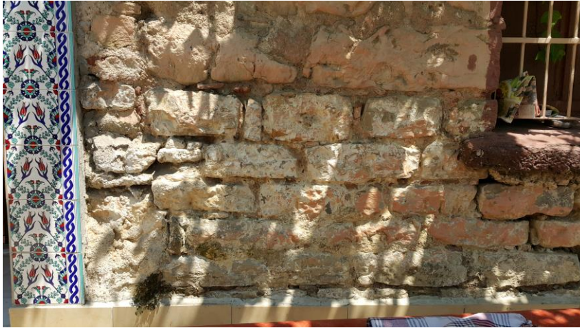
Şekil A.156 : Batı cephesi taş örgüsü.
