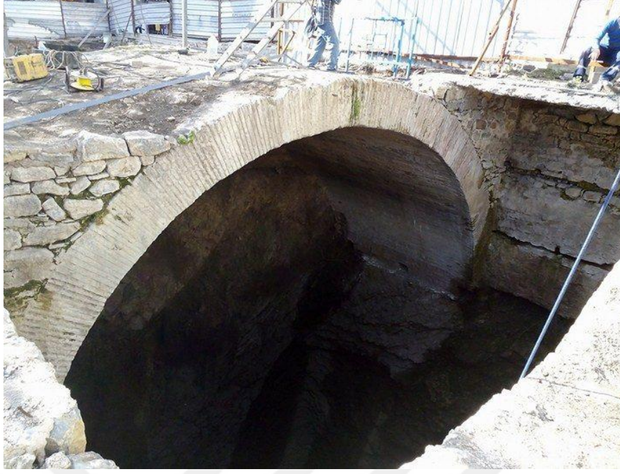
Şekil A.10 : Çarşı Hamamı'nın kuzeyinde bulunan su sarnıcı. ( http://www.marmaragazetesi.com )
