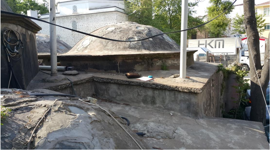
Şekil A.208 : Isıtma sistemine ait tüteklikler.
