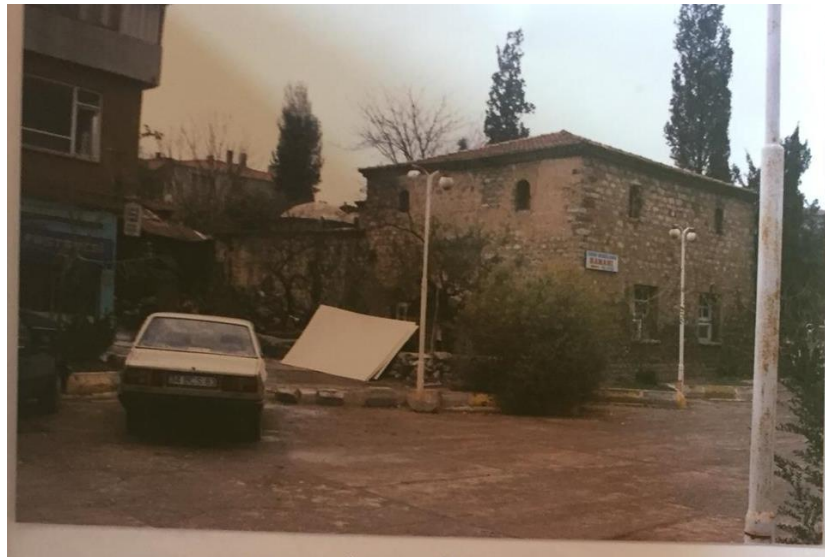
Şekil B.2 : Menzilhane Hamamı cephesi (K.K.V.K.K. Arşivi, 1990).
