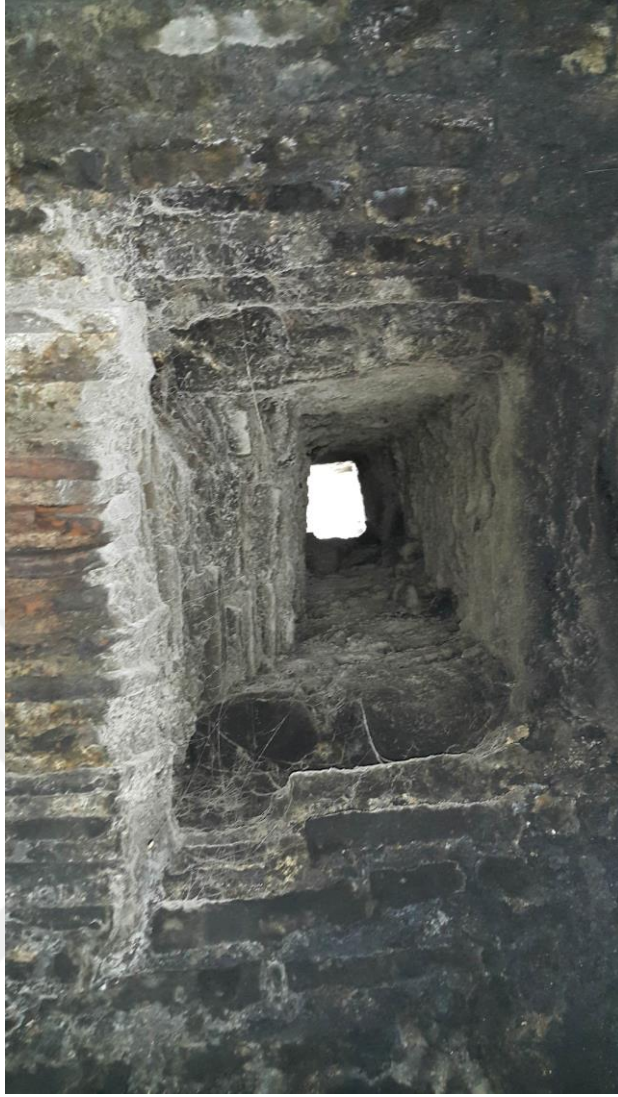
Şekil A.141 : Külhana ait duman bacası.
