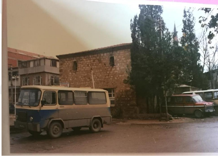
Şekil B.4 : Menzilhane Hamamı cephesi (K.K.V.K.K. Arşivi, 1990).
