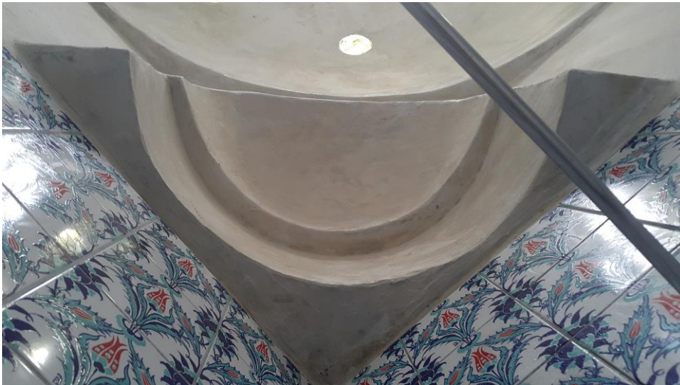
Şekil A.198 : Halvet hücreleri tromp.
