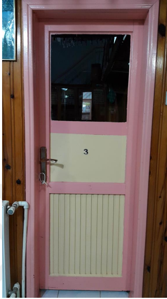
Şekil A.55 : Soyunmalık bölümü oda kapıları.
