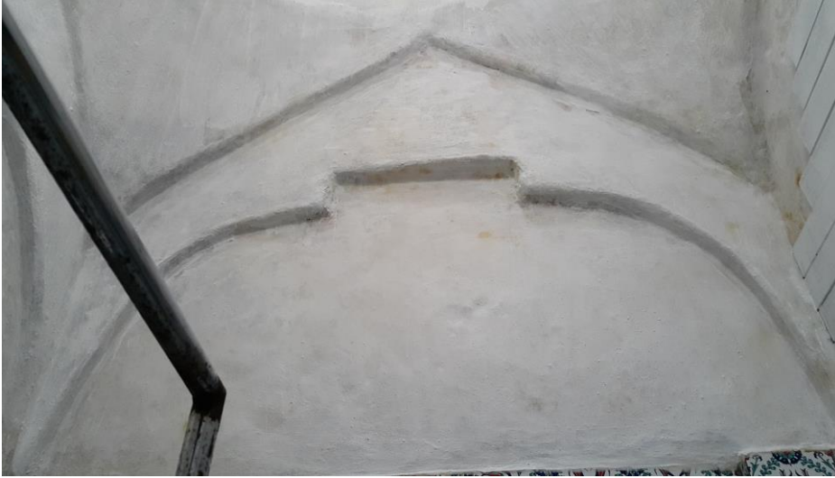
Şekil A.94 : Z11 batı duvarı kemerleri.
