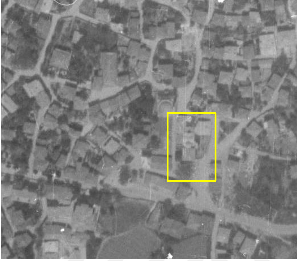
Şekil B.23 : Menzilhane Hamamı hava fotoğrafı (H.G.M., 1968).
