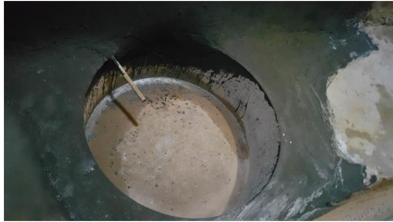
Şekil A.132 : Su deposuna ait kazan.
