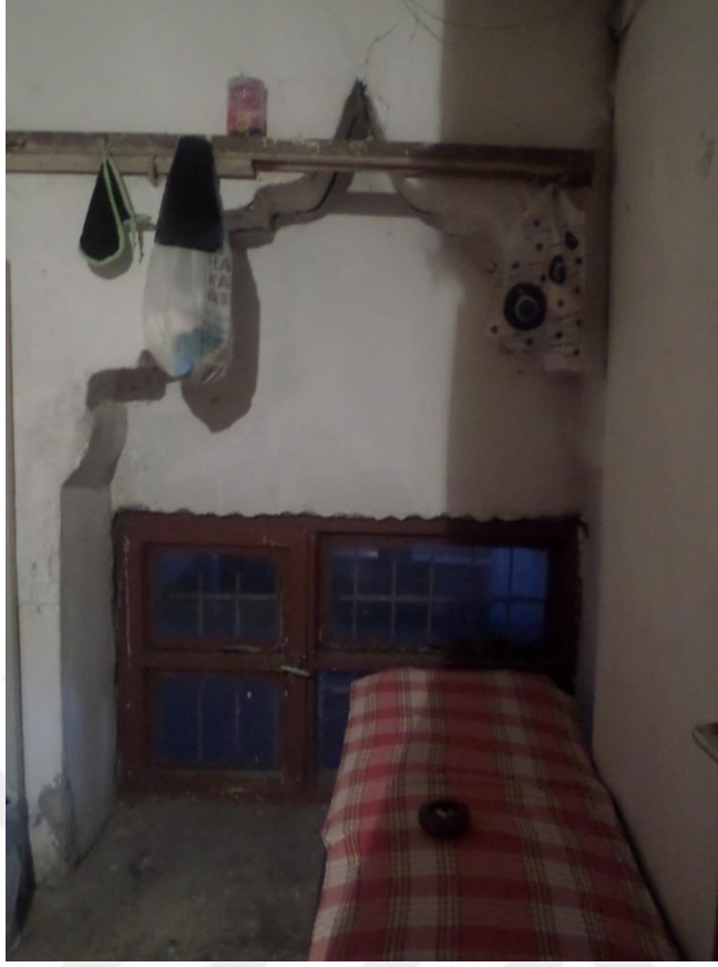
Şekil A.47 : P3 penceresi asma kattan görünüm.
