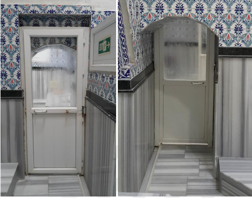
Şekil A.191 : Z14 – Z15 arasındaki kemerli geçiş.
