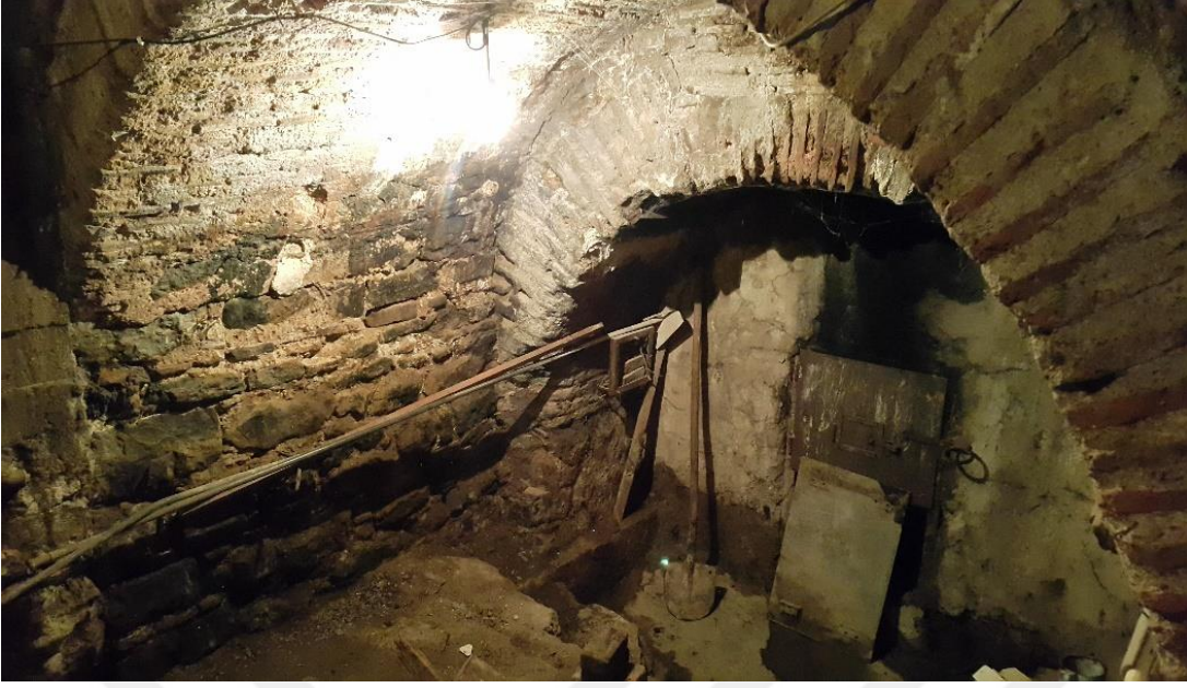
Şekil A.137 : Külhanda yer alan iki kademeli tuğla tonoz.
