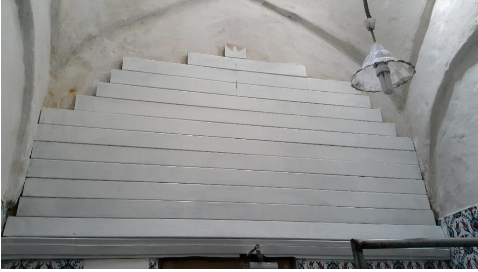
Şekil A.89 : Z11 ile Z13 arasında sonradan örülen duvar.
