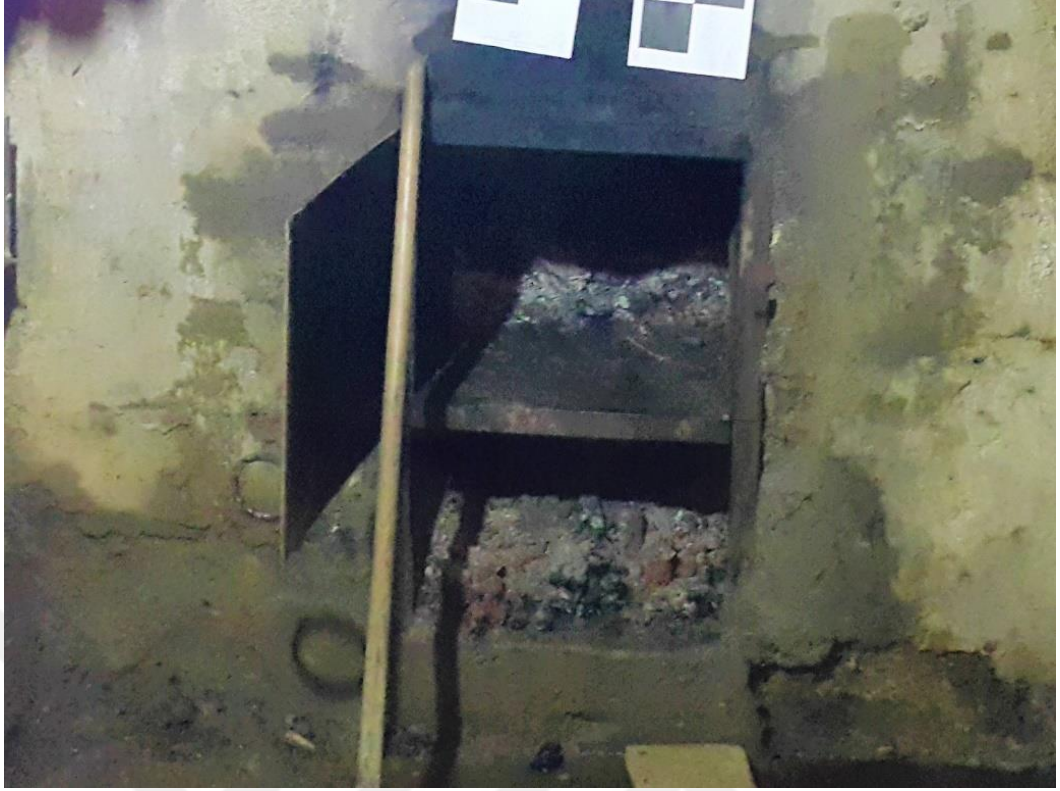
Şekil A.139 : Külhanda ocağı örten metal kapak.
