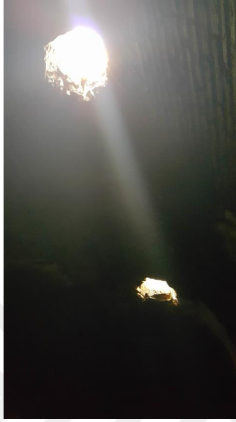
Şekil A.133 : Su deposu tuğla tonoz örgüsü.
