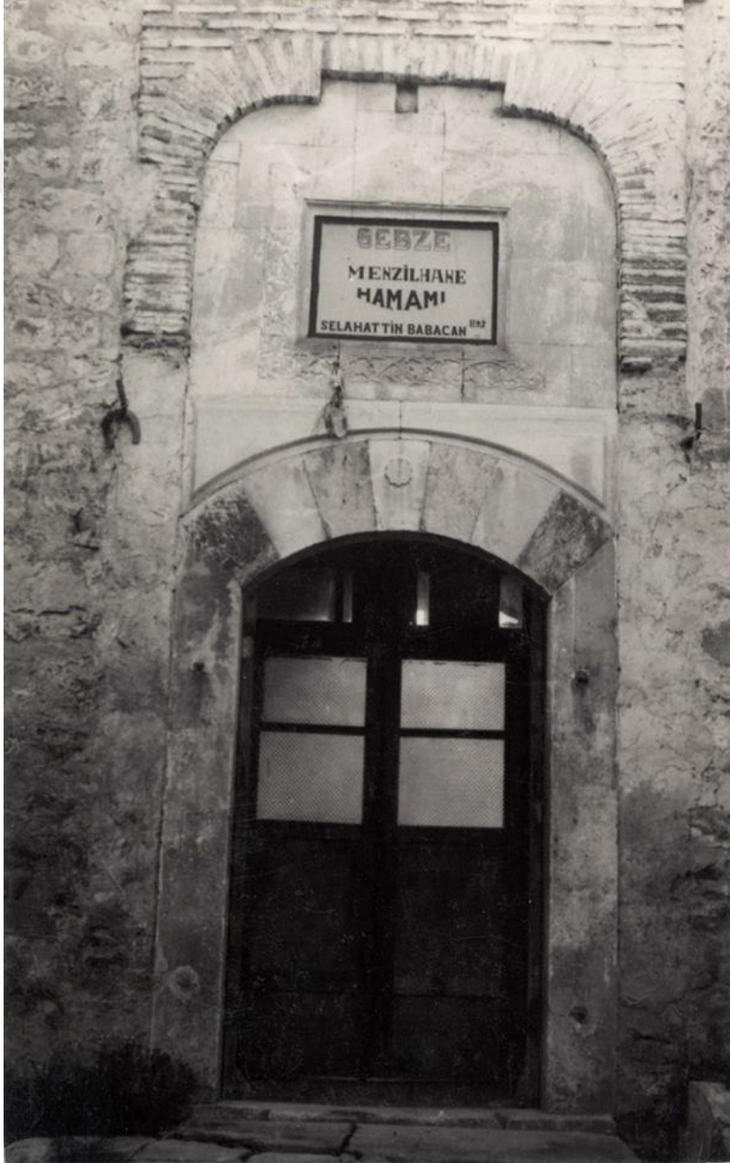
Şekil B.20 : Menzilhane Hamamı giriş kapısı (Ülgen Arşivi, 1960 Öncesi).
