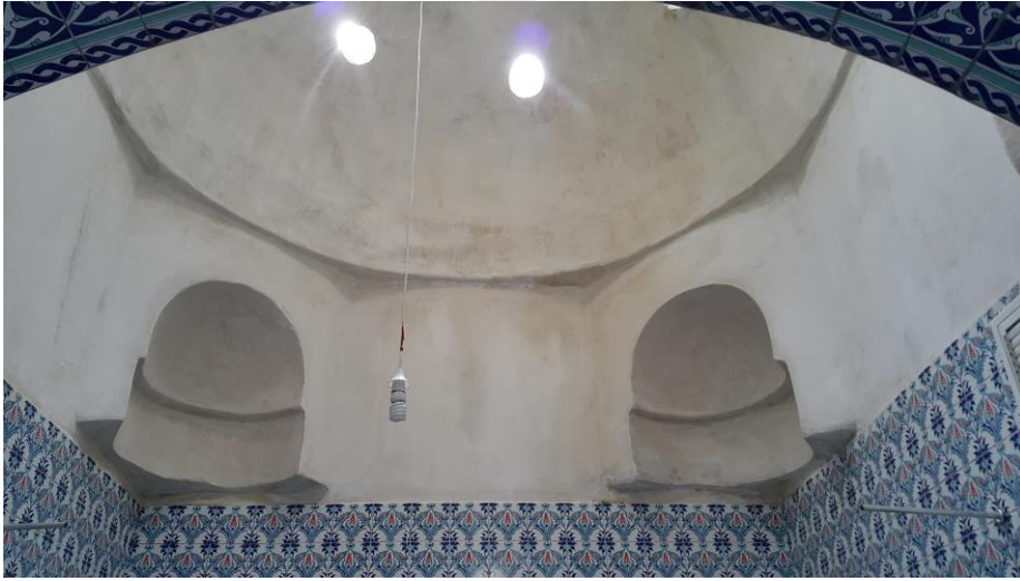
Şekil A.197 : Halvet hücreleri tromp.
