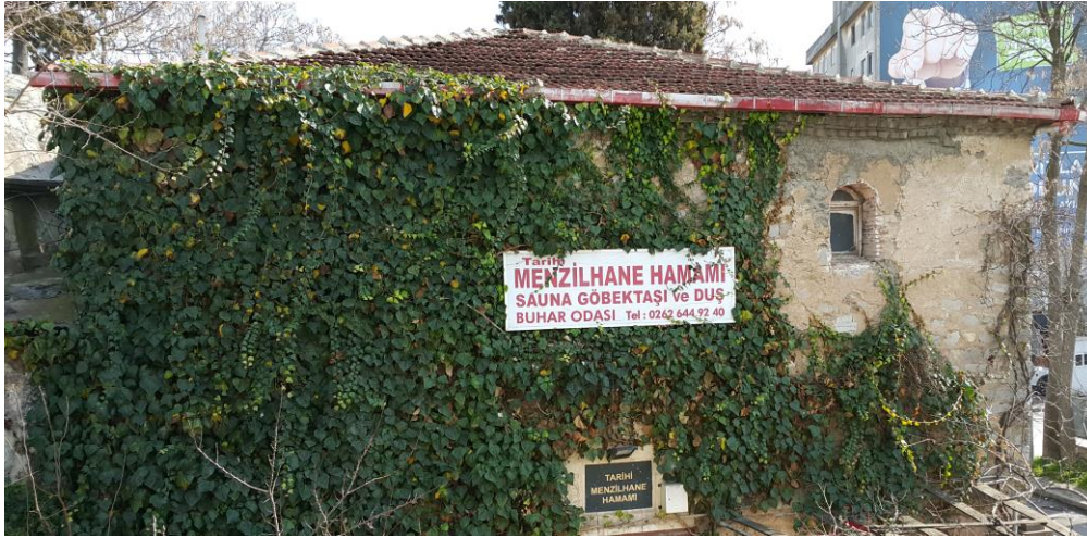
Şekil A.52 : Soyunmalık bölümü çatı örtüsü.
