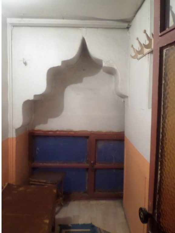
Şekil A.46 : P2 penceresi asma kattan görünüm.
