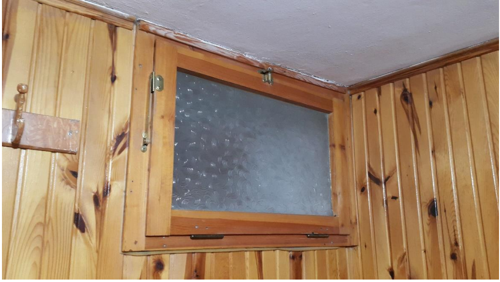
Şekil A.49 : P3 penceresi zemin kattan görünüm.
