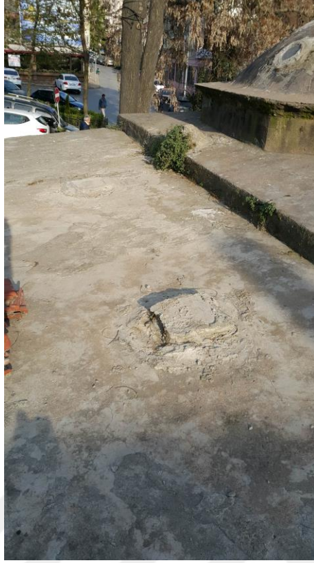
Şekil A.135 : Su deposunda kapatılan ışıklıklar.
