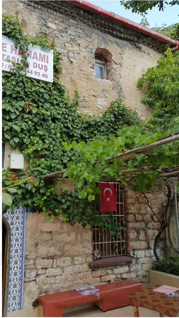
Şekil A.157 : Batı cephesinde uygulanmış farklı sıva görünümü.
