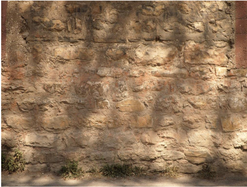
Şekil A.167 : Güney cephesi duvar örgüsü.
