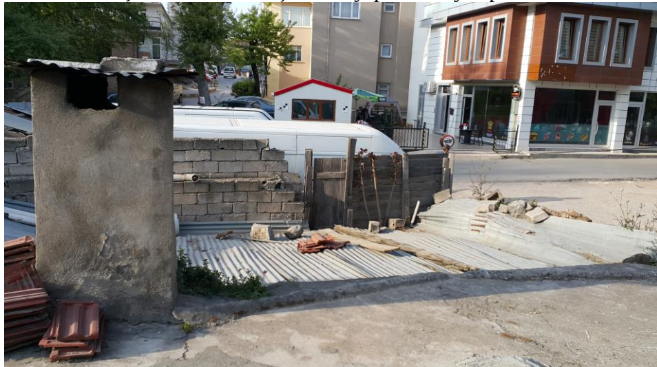
Şekil A.181 : Kuzey duvarı çatı giriş kapısı.
