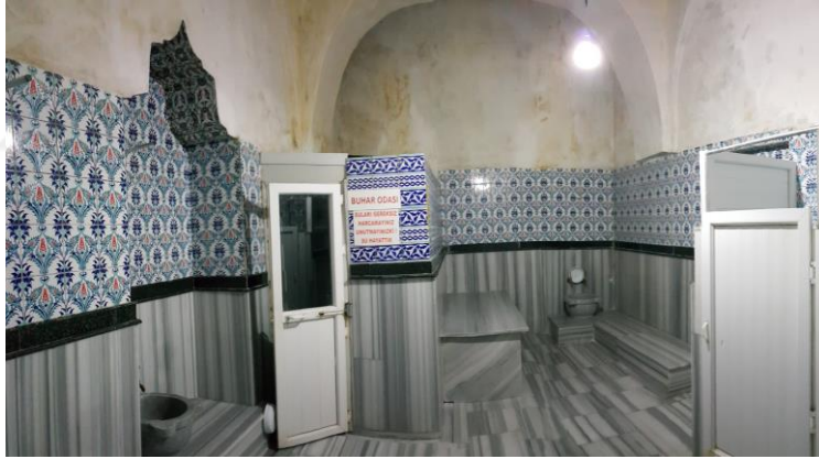
Şekil A.105 : Z14 sıcaklık genel görünüm.
