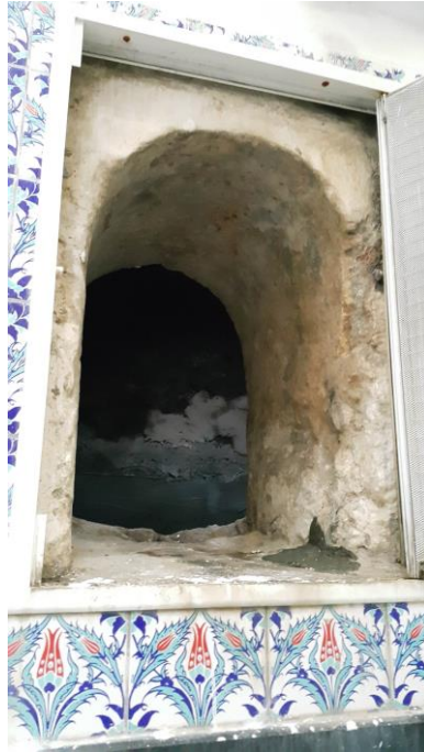
Şekil A.129 : Hücreler ve su deposu arasındaki pencere.
