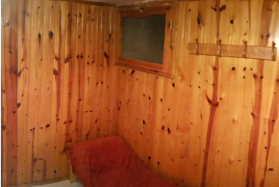
Şekil A.48 : P2 penceresi zemin kattan görünüm.
