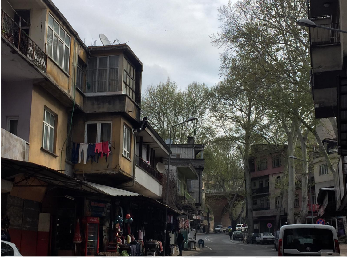
Foto 3. 2. Saha Çalışmasından Mahalle Tipi 2-4 Kat Arası Olan Bina Örneği (Yusuflar Mahallesi/Dulkadiroğlu İlçesi)
