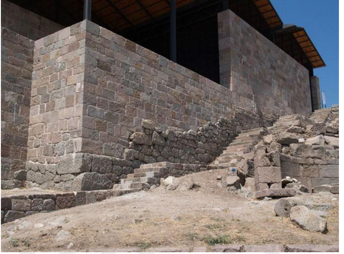
Levha 34: Bergama Z yapısı antik duvarların onarımı (Deutsches Arch ologisches Institut, Pergamon, Z yapısı)
