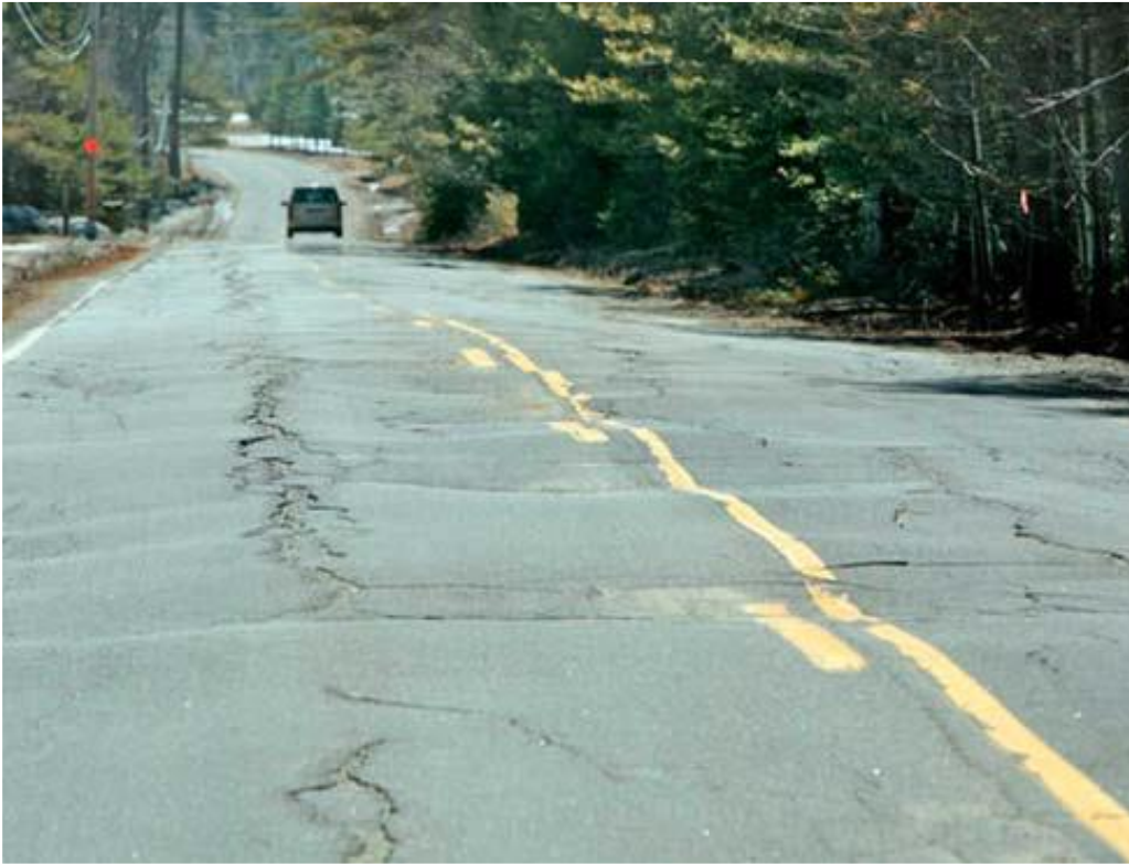
Şekil 2.15 : Esnek üstyapılarda Kabarma Türü Yol Bozulması [30].
