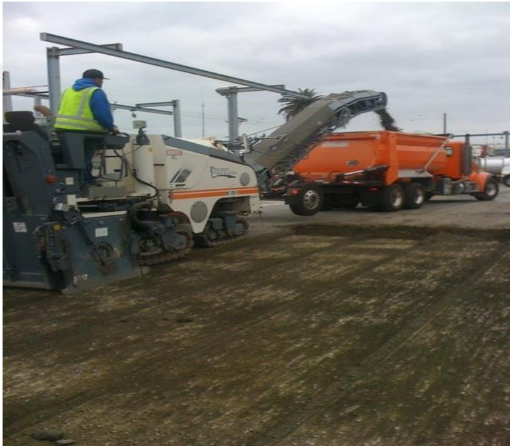
Şekil 2.22 : Soğuk Düzeltme (Cold Planing) uygulaması [34].
