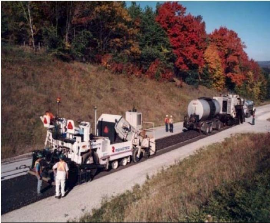
Şekil 2.24 : Soğuk yerinde geri dönüşüm uygulaması [13].
