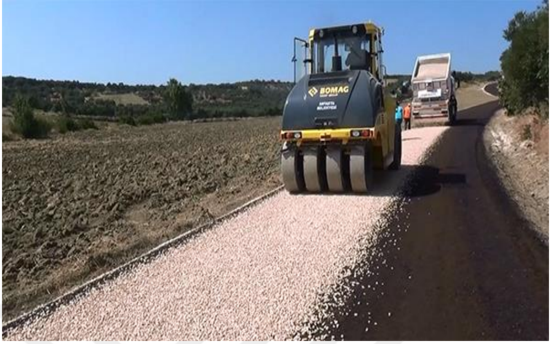
Şekil 2.3 : Sathi kaplama serme ve sıkıştırma uygulaması.
