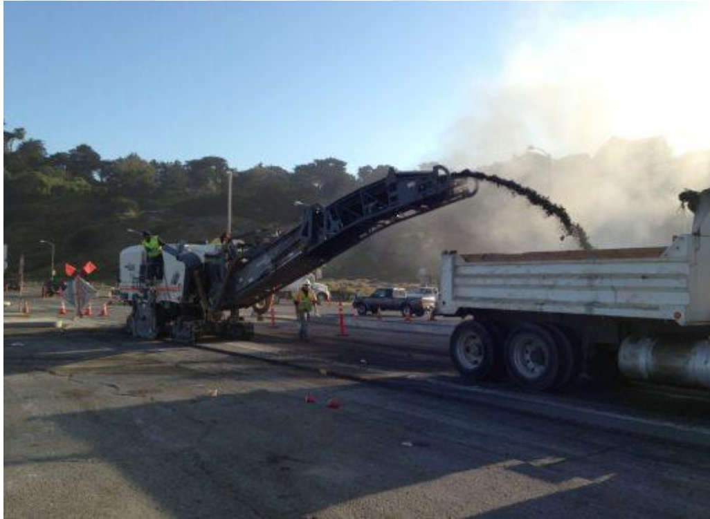
Şekil 3.1 : Asfalt kazıma makinesi çalışma görüntüsü [36].
