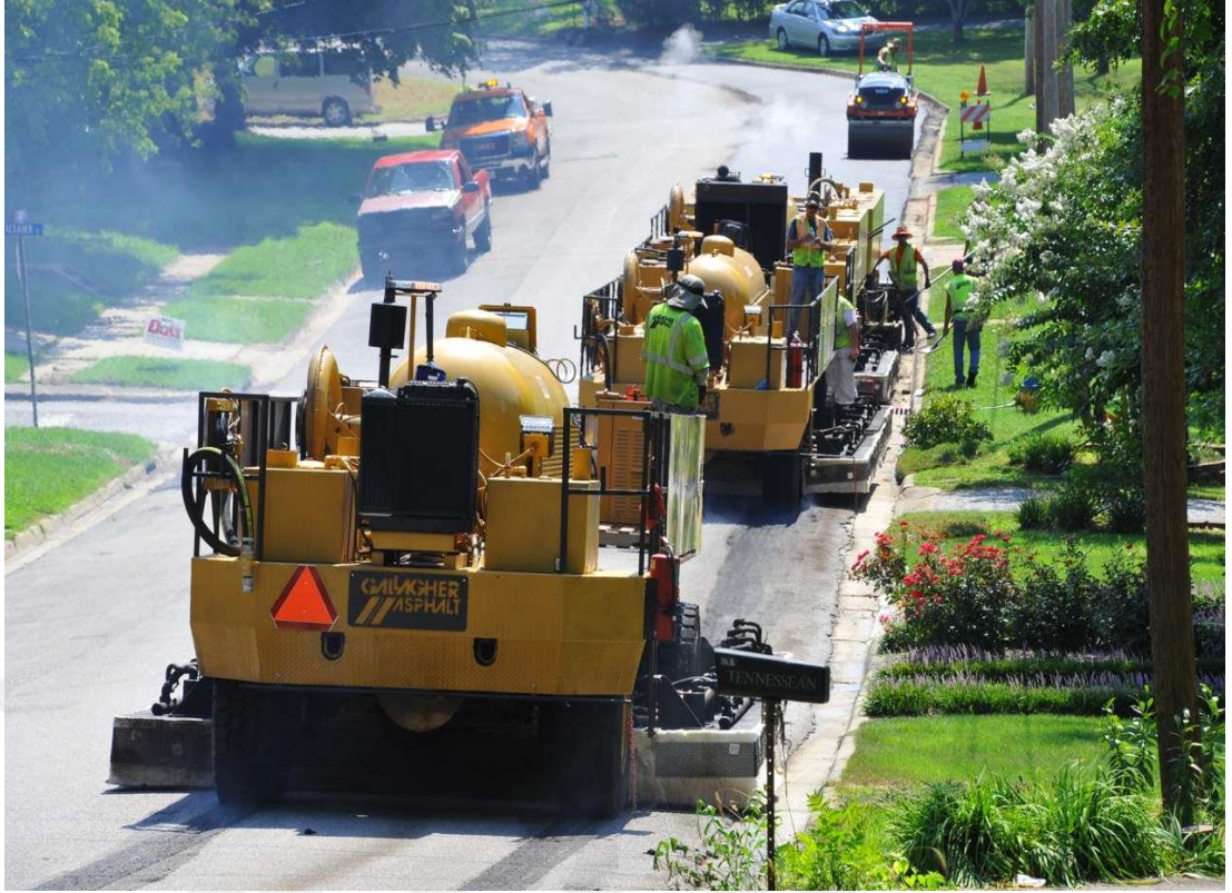
Şekil 2.23 : Sıcak yerinde dönüşüm uygulaması [35].
