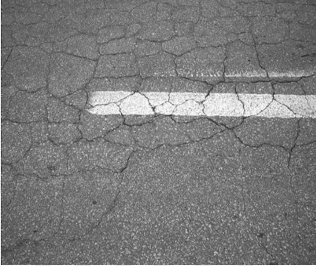
Şekil 2.18 : Esnek Üstyapılarda timsah sırtı türü yol bozulmaları.
