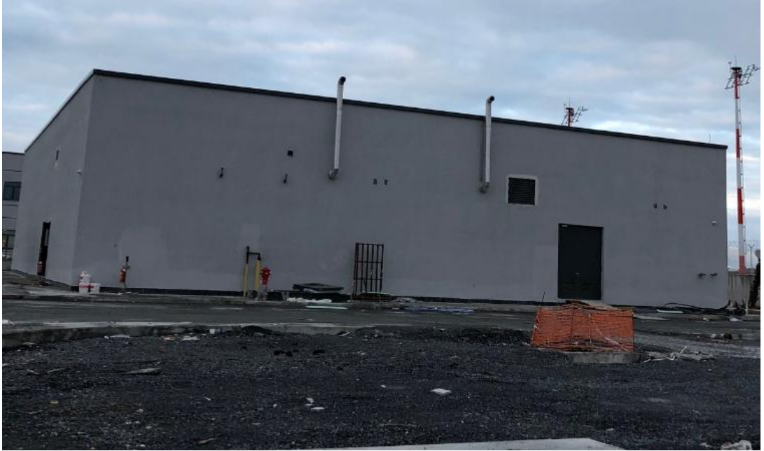
Şekil 4.1 İstanbul Havalimanı kampüsü yangın pompa dairesi
