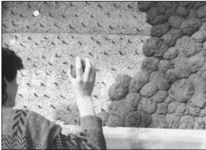
Şekil 1.12. Çarpma kil sıva uygulaması [1].
