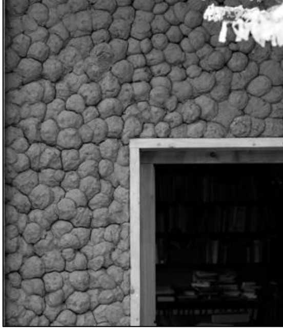
Şekil 1.13. Çarpma kil sıva uygulaması [1].
