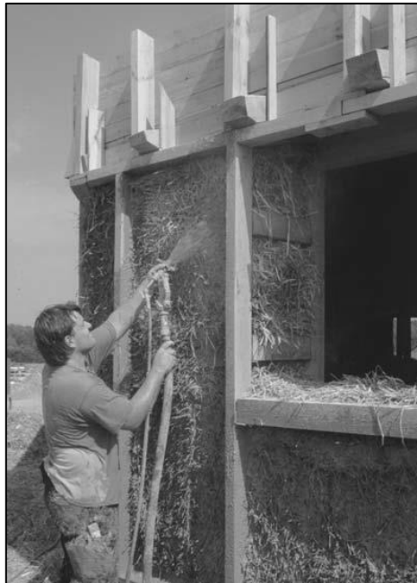
Şekil 1.14. Saman balyalı kil sıva uygulaması[1].
