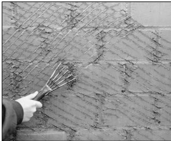
Şekil 1.8. Kil sıvaların tırmıklı mala yardımıyla pürüzlü hale getirilmesi [1].
