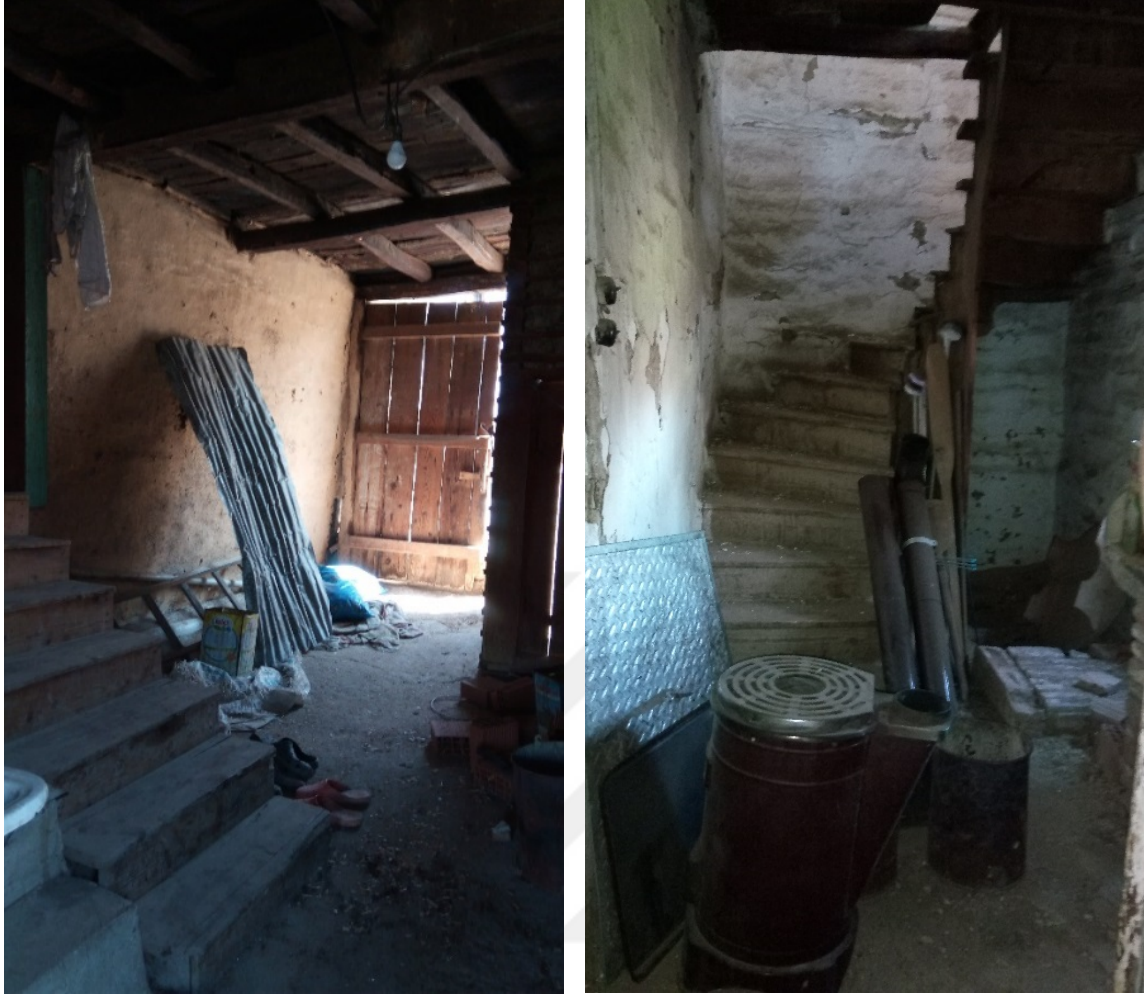
Resim 4.43. Olgunlar evinin zemin kattaki taşlık ve merdiven holü
