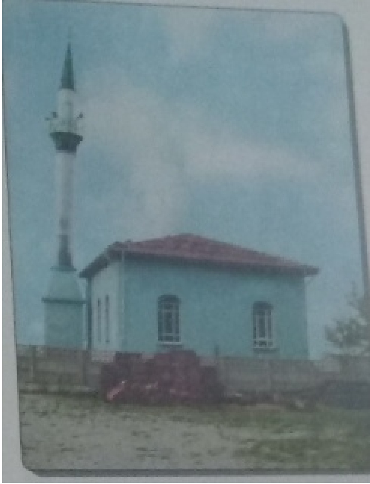
Resim 3.83. Çaylıca Köyü Camisi (Bursa Müftülüğü, 2004:187)
