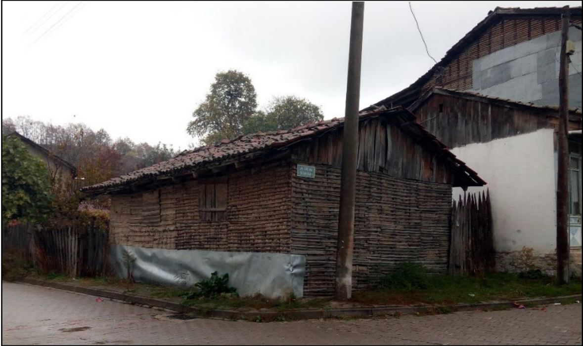
Resim 5.25. Bağdadi yapım tekniği ile inşa edilmiş müstemilat
