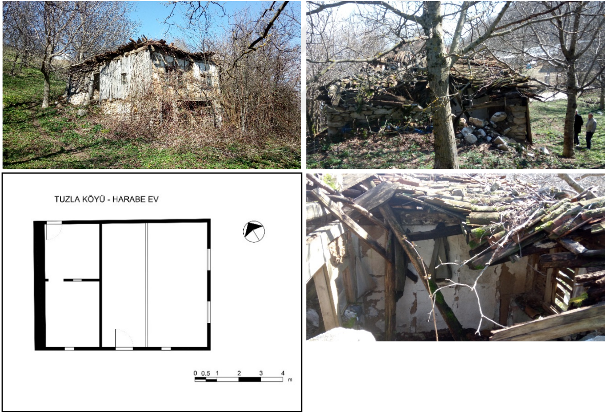
Resim 3.24. Tuzla köyünde yapılan ilk evlerden biri ve planı
