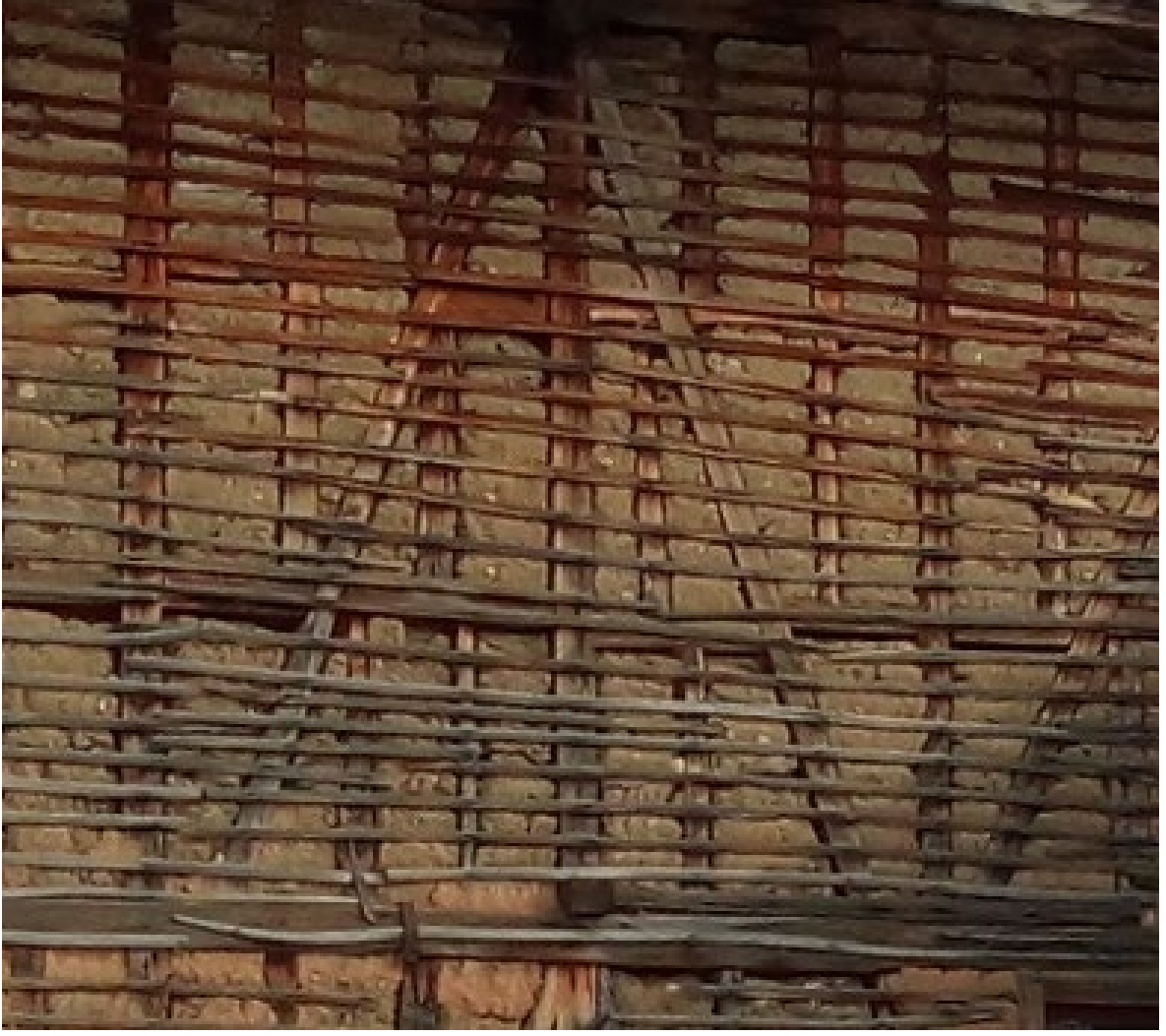
Resim 5.22. Tahtaköprü evlerinde bağdadi duvar
