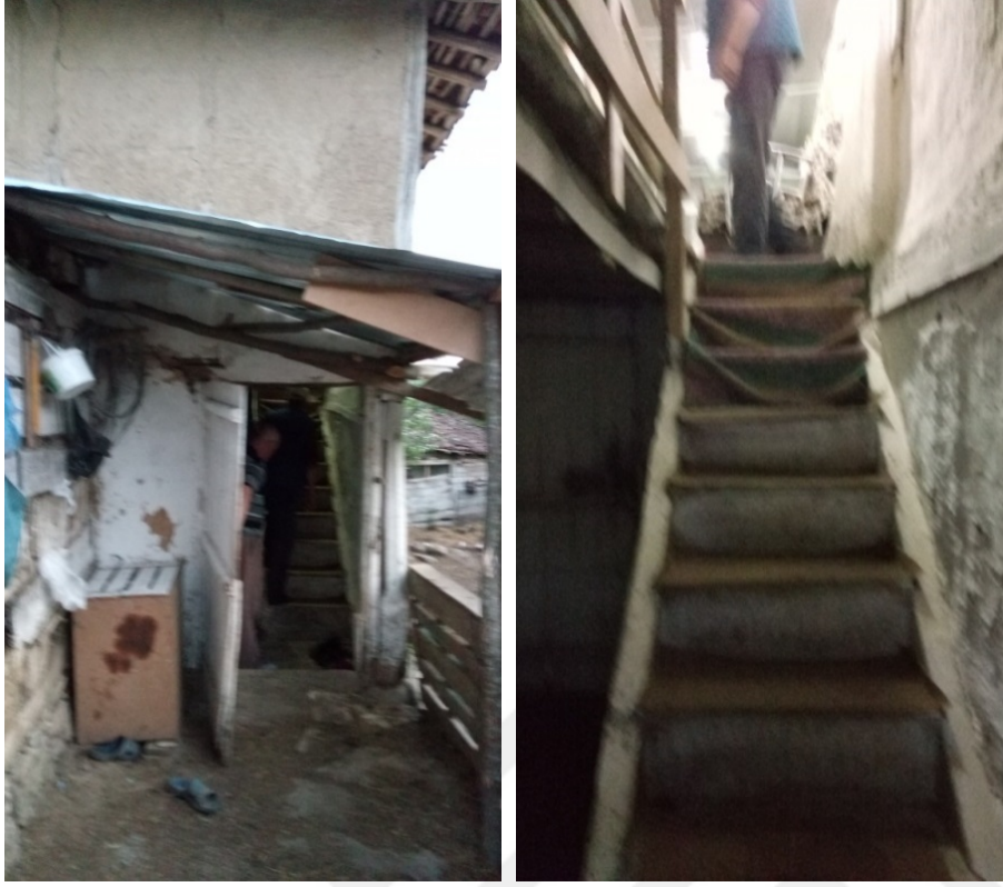
Resim 3.63. Hasan Aybey evi zemin kattan görünüş
