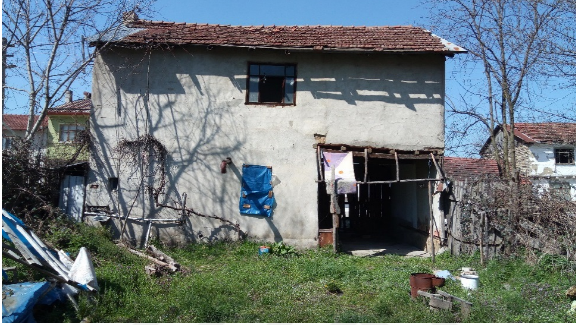
Resim 4.55. Ayşe Türkmen evi avlu cephesi
