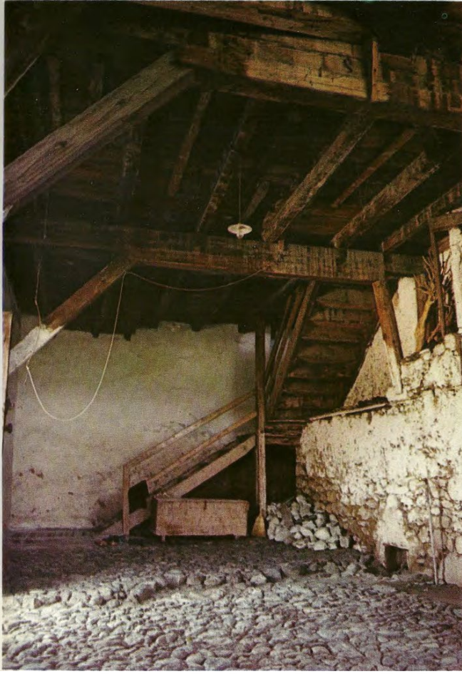
Resim 5.5. Türk evinde doğal yapı ile üst kat arasındaki bağlantıyı gerçekleştiren giriş katının iç görünüşü (Küçükerman, 2007:35)
