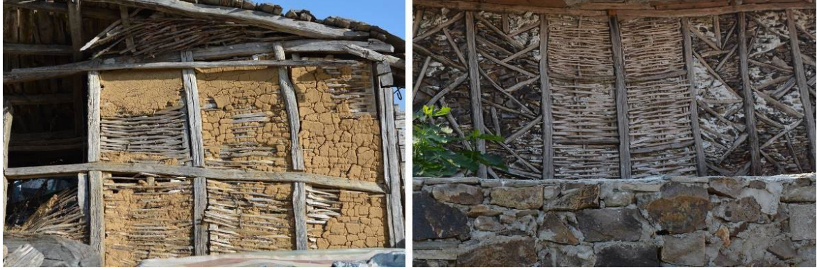
Resim 5.24. Ahşap çerçeveli yapılar a)Pomak yerleşiminde bağdadi yapı b)Pomak yerleşiminde bağdadi ve çatma kombinasyonu yapı (Sinamides,2017)
