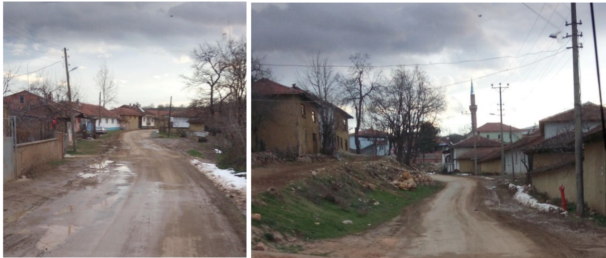
Resim 3.66. Tekkeköy yol hattından görünüş
