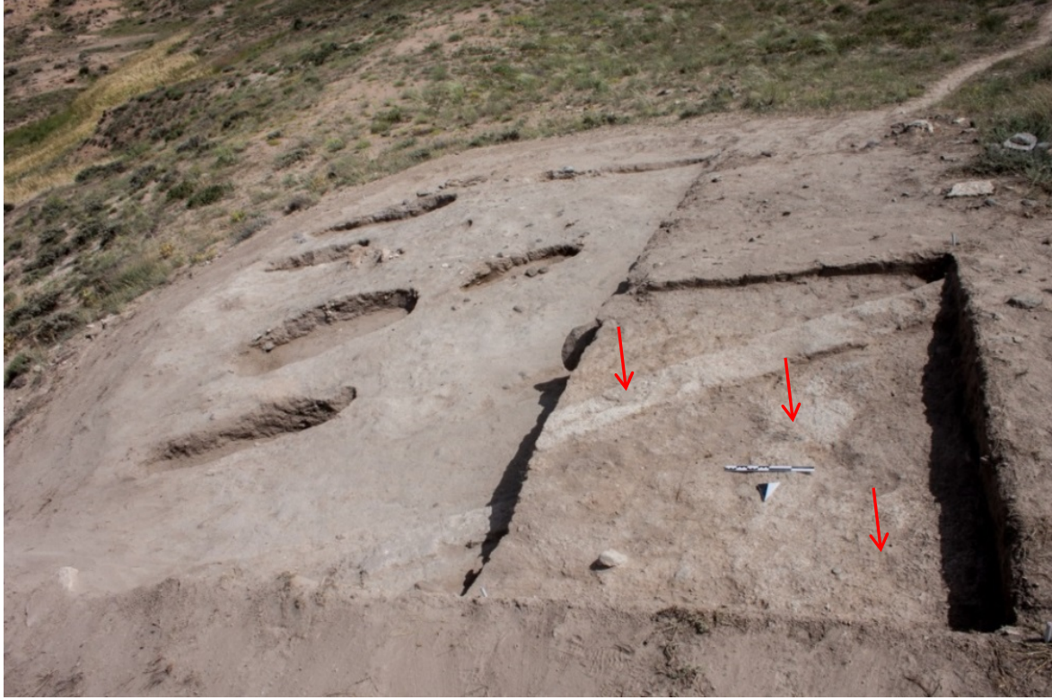
Resim 3.8. Osmanlı Dönemi mezarları tarafından tahrip edilmiş kerpiç yapılar.
