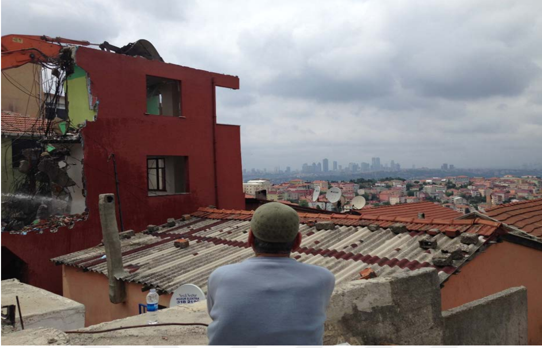
Şekil 4.47: Dönüşüm kapsamında yıkılan bina
