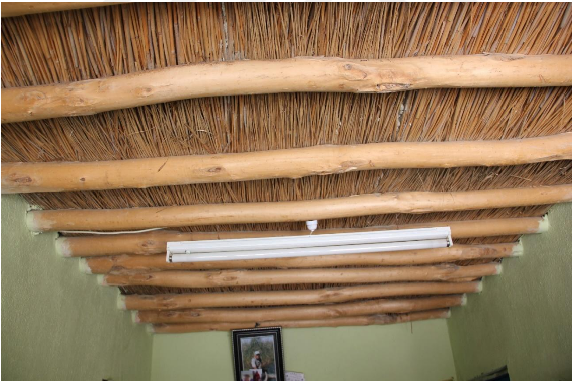
Phragmites australis L. 'in evlerde çatı altı örtüsü olarak kullanımı-1
