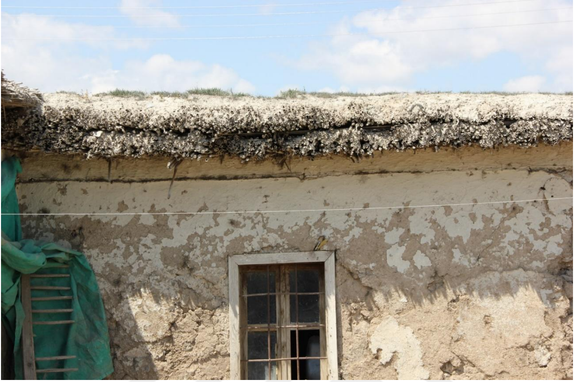
Phragmites australis L. 'in evlerde çatı olarak kullanımı-1
