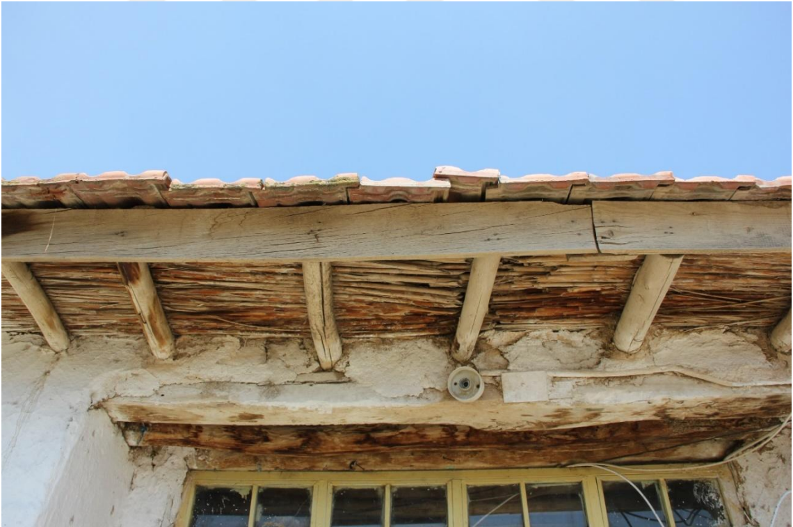
Phragmites australis L. 'in evlerde çatı olarak kullanımı-2
