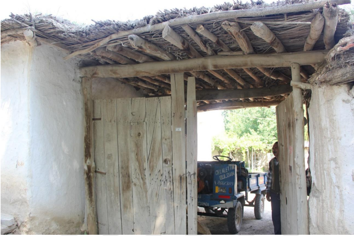
Phragmites australis L. 'in evlerde çatı olarak kullanımı-3
