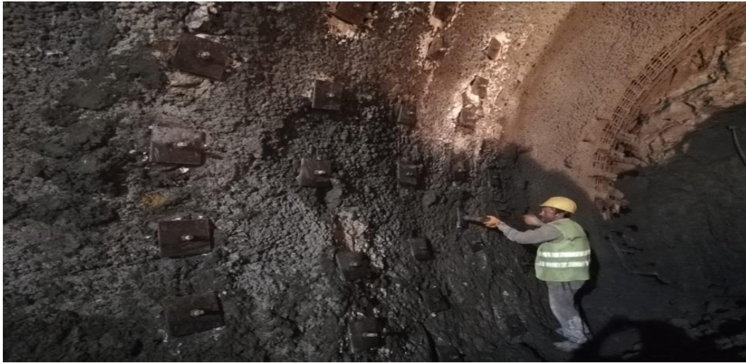
Şekil 5.3: Zemin çivisi tork kontrolü
