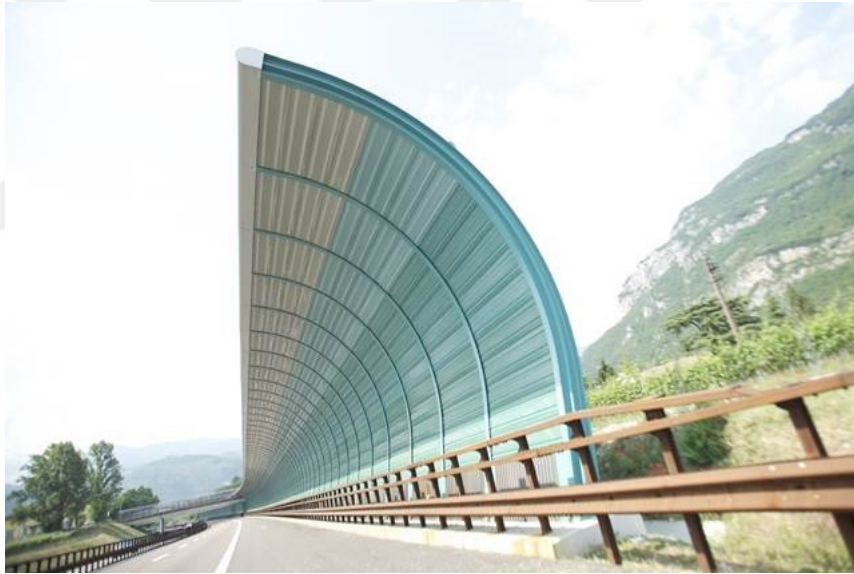
Şekil 2.18 Otoyol kenarına yerleştirilen oyuk geçirimsiz bariyer [20]
