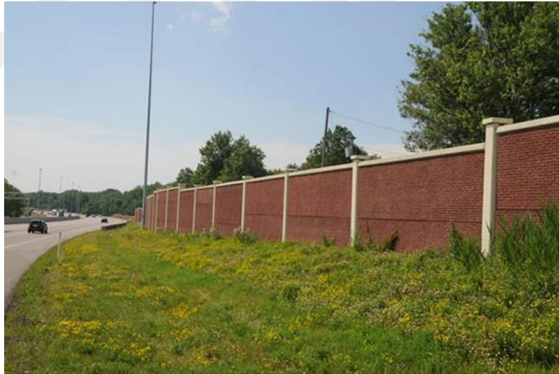
Şekil 2.17 Tuğla gürültü engeli [42]
