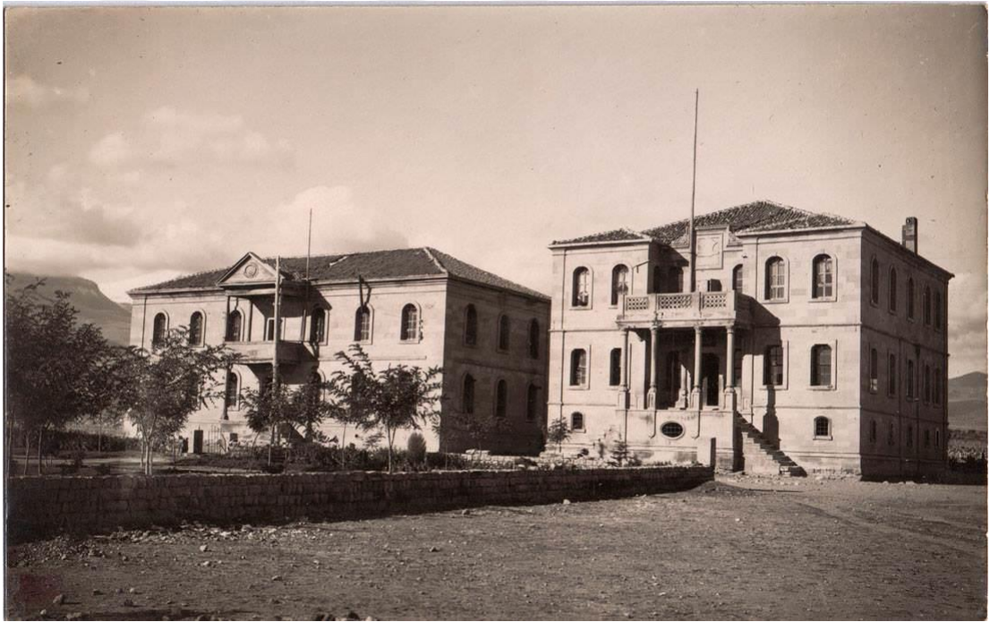
Şekil 3.6. Askerlik şubesi ve lojmanı 1937 (develi belediyesi arşivi).
