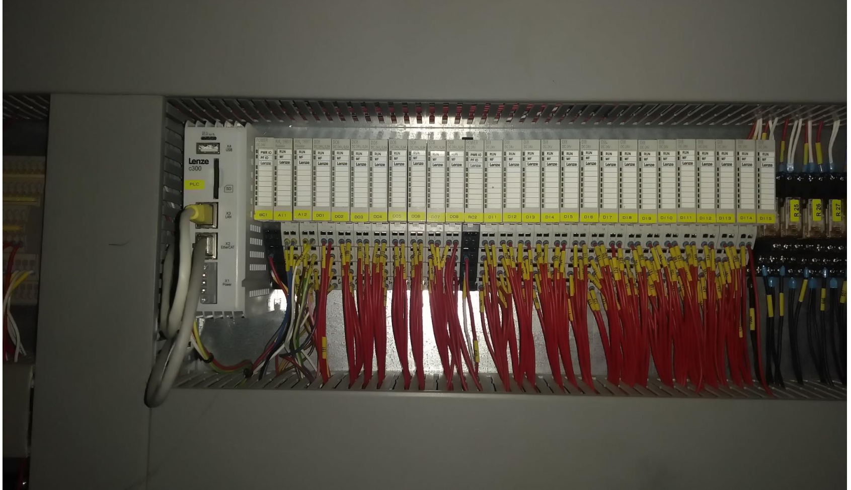
Şekil C.7 : PLC ve giriş çıkış modülleri.
