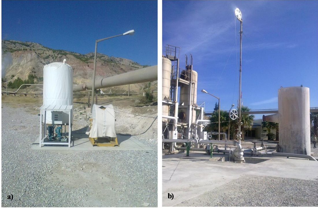
Şekil 1.8: Mineral çökelmesini engellemek için sahada kullanı İnhibitör düzeneği. İnhibitör pompa aracılığıyla depodan emilip (a), kapiler boru vasıtasıyla, kuyu başındaki makara sisteminden geçerek kuyu içine gönderilmektedir (b).
