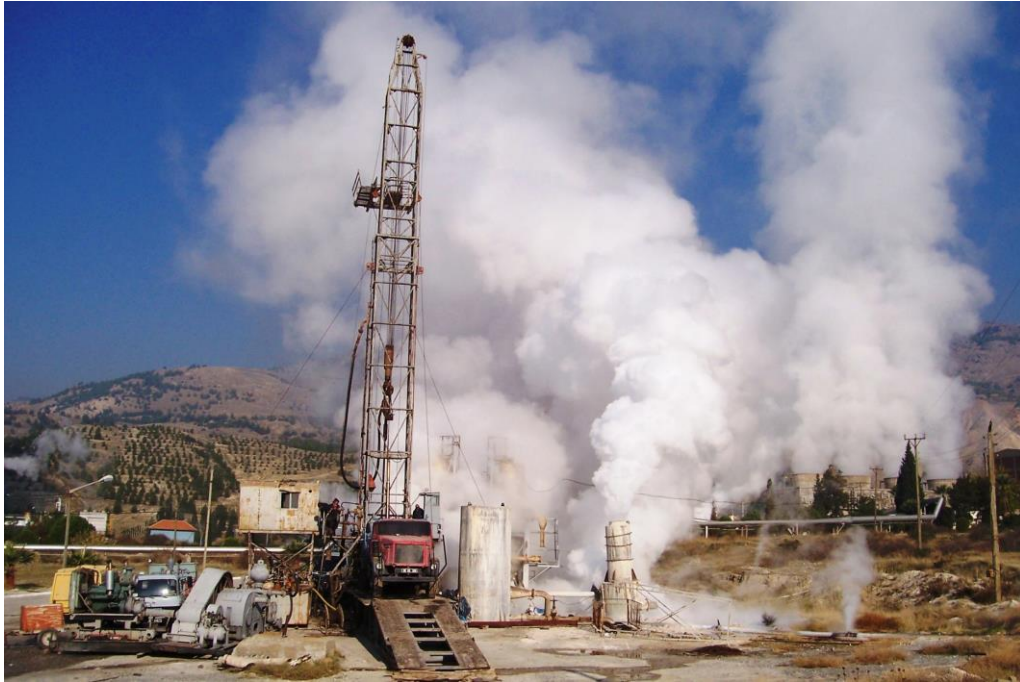
Şekil 1.7: İnhibitör öncesinde sahada uygulanan mekanik temizlik operasyonu.
