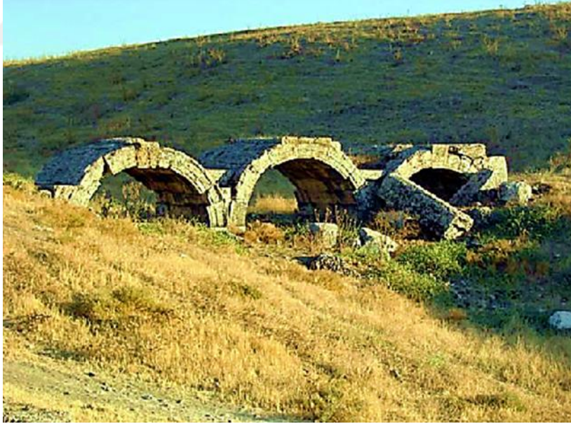
Şekil 3.22. Laodikeia Kenti Ephesos Kapısı (Özgen, 2009)
