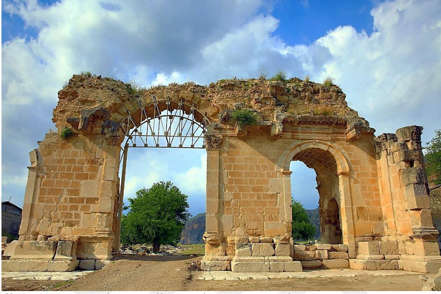
Şekil 3. 15. Anazarbos Antik Kenti Kent Anıtsal Kent Kapısı Güney Cephe (Anazarbos Kazı Arşivi)
