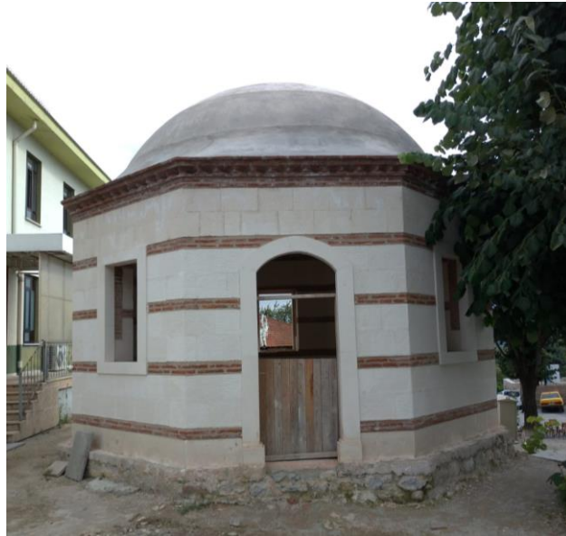
Şekil 2.33 Konuralp Türbesi' nin restorasyon uygulama aşaması
