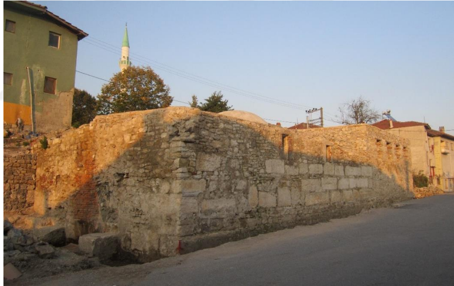
Şekil 2.25 Konuralp Hamamı restorasyon çalışmasında ortaya çıkan güney duvarı
