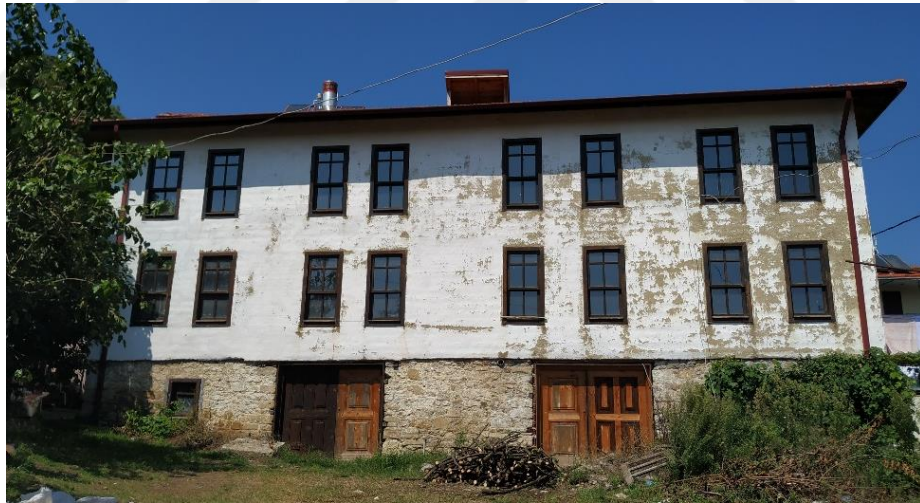
Şekil 5.21 Pansiyon işlevi verilen 1825-1826 parsellerinde yer alan tescilli yapı
