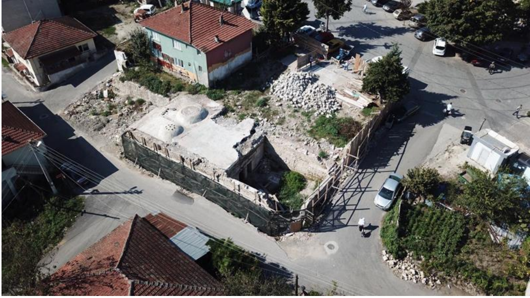
Şekil 5.20 Tarihi Osmanlı Hamamı restorasyon çalışmaları [41]
