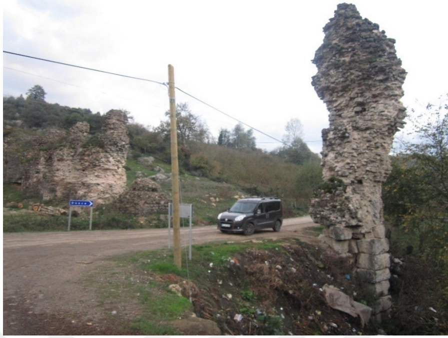
Şekil 5.10 Kemerkasım Su Kemer kalıntıları
