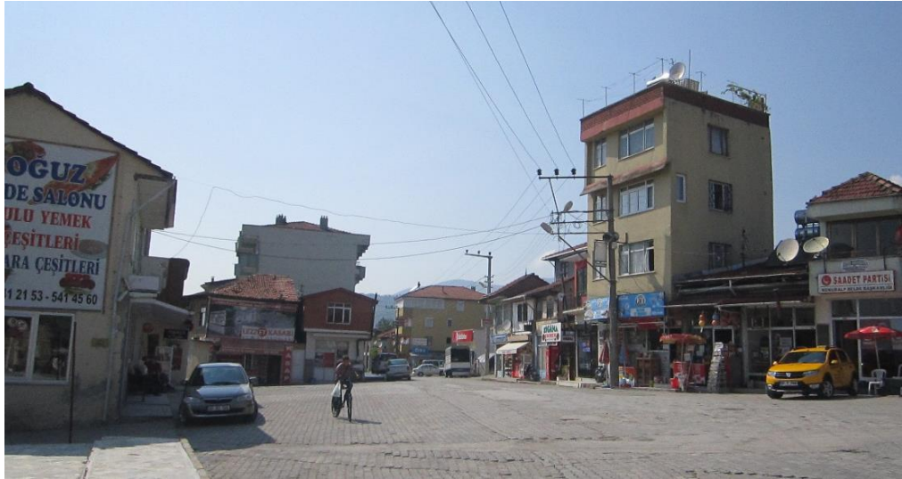
Şekil 6.22 Meydan çevresinde yer alan niteliksiz yapılar
