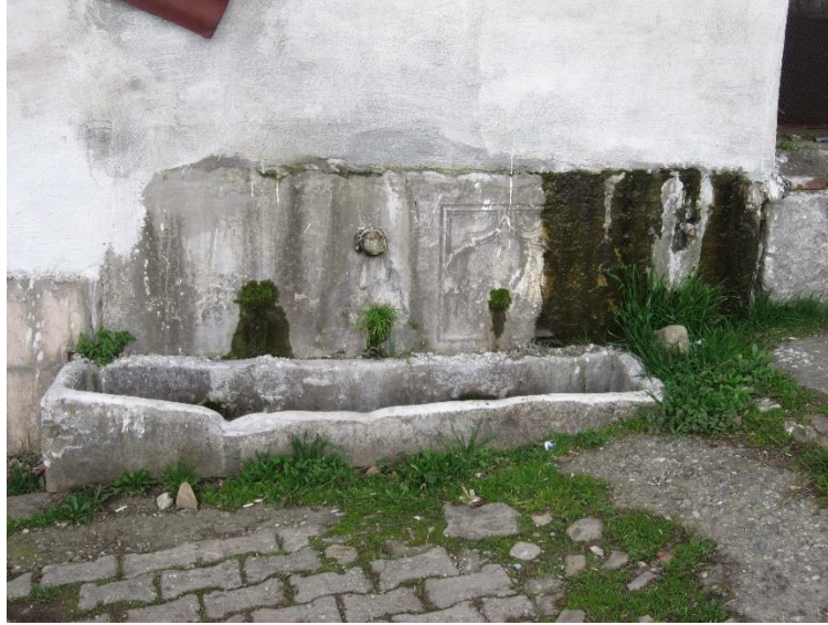
Şekil 2.36 Restorasyondan önce havuzun batı duvarında yer alan çeşme ve yalak
