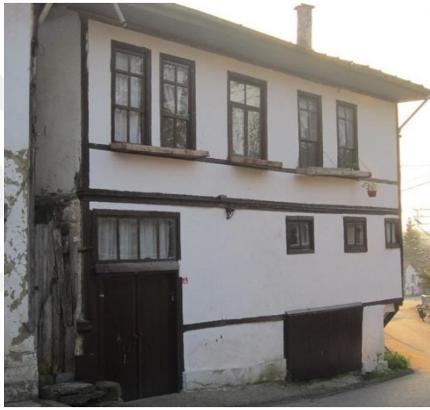
Şekil 6.3 2015 parselinde yer alan tescilli yapı
