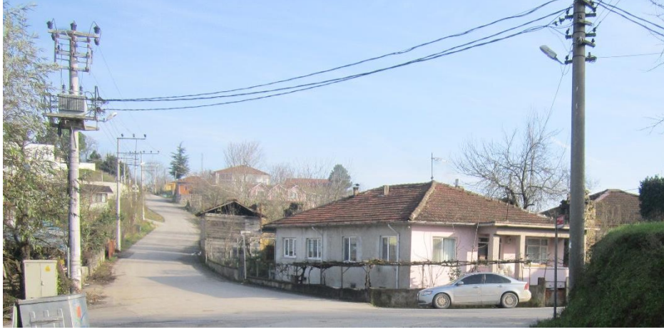
Şekil 4.24 Elektrik direk kullanımı
