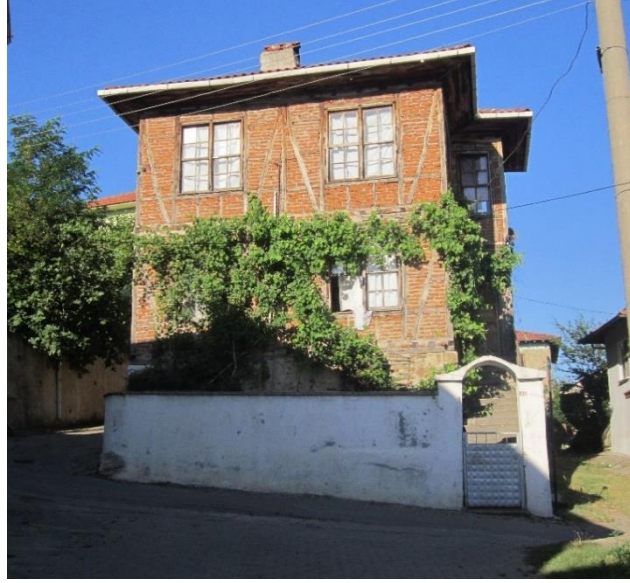
Şekil 3.7 Taş bahçe duvarından giriş yapılan yapı örneği
