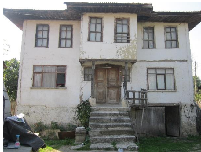
Şekil 6.2 1161 parselde yer alan tescilli yapı
