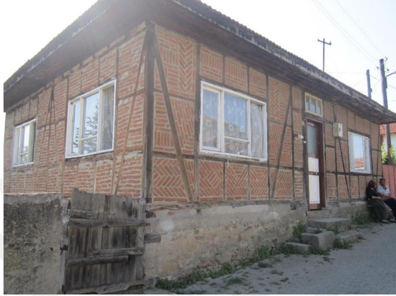
Şekil 3.10 Sokaktan hem yapıya hem bahçeye giriş yapılan yapı örneği
