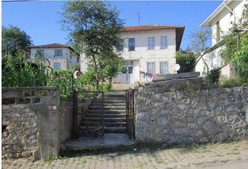
Şekil 3.8 Moloz taş örgüsü bahçe duvarından giriş yapılan yapı örneği
