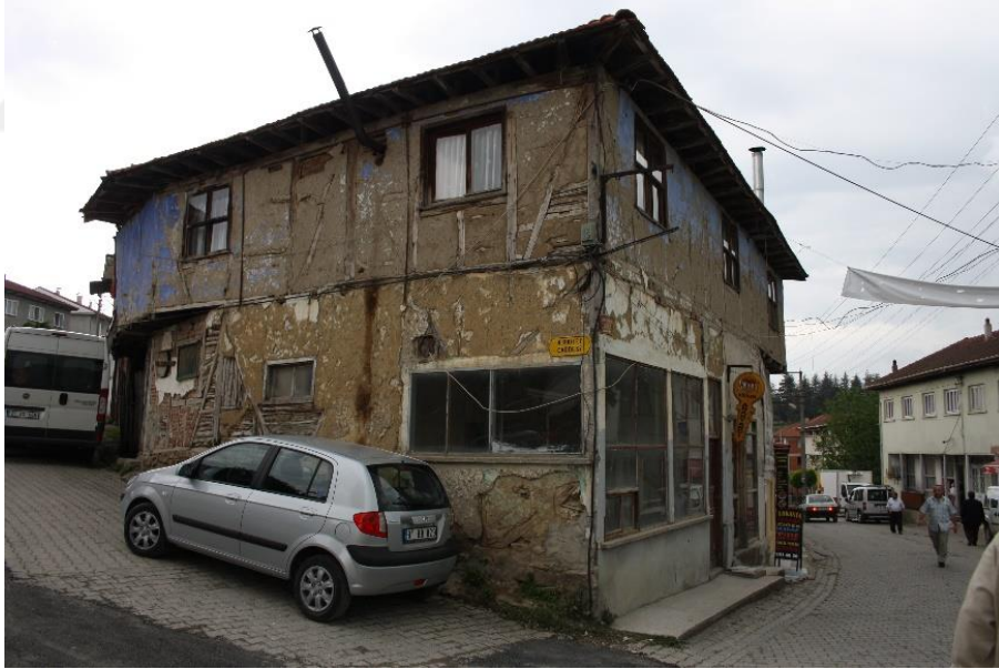
Şekil 6.26 Kooperatif işlevi verilmesi önerilen yapı
