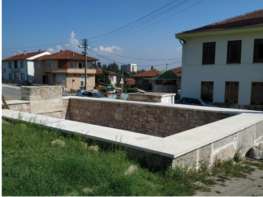
řekil 2.34 Kilise Suyu eřmesi havuz duvarları
