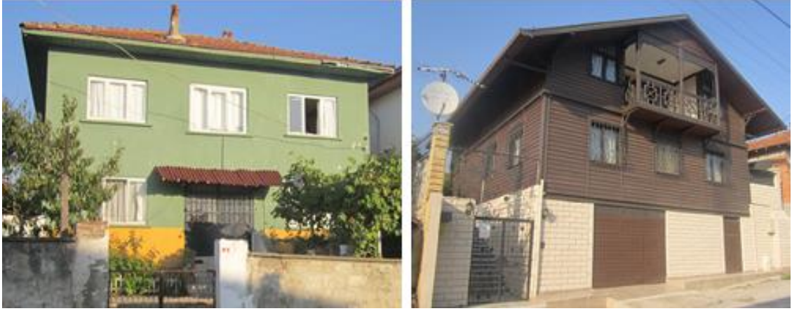
Şekil 4.56 Cephe düzeni korunmamış yapı örnekleri
