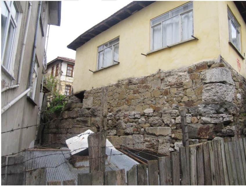
Şekil 2.13 Güney sur duvarı
