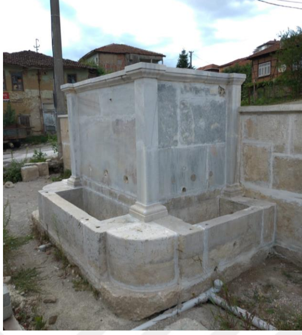
Şekil 2.35 Havuz güney duvarında yer alan çeşme
