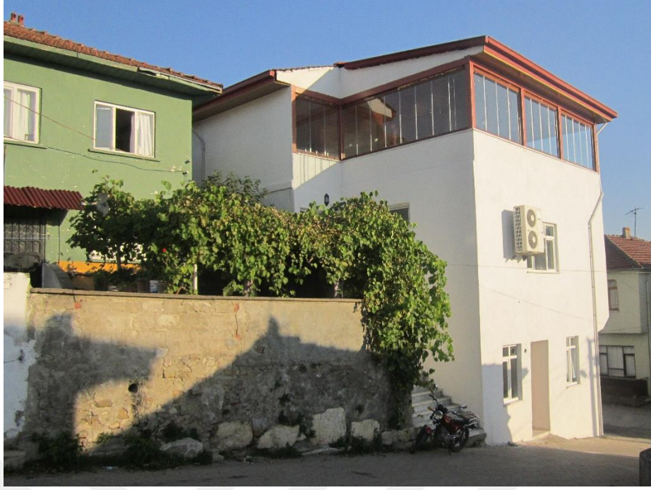
Şekil 2.24 Hamam üzerine inşa edilen yapı
