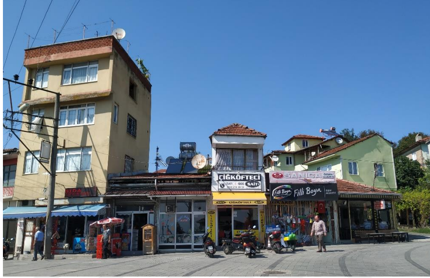
Şekil 6.23 Meydan çevresinde yer alan niteliksiz yapılar
