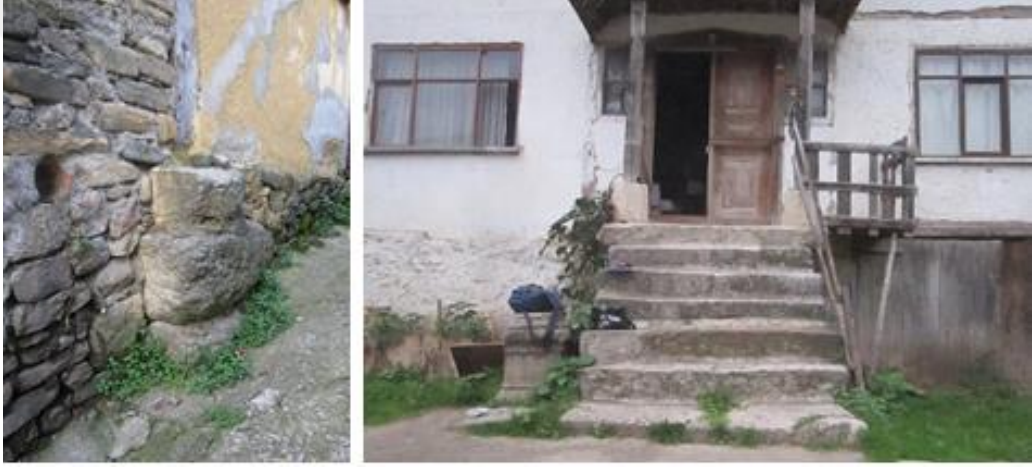
Şekil 4.14 Yapı elemanı olarak kullanılan devşirme malzeme örnekleri
