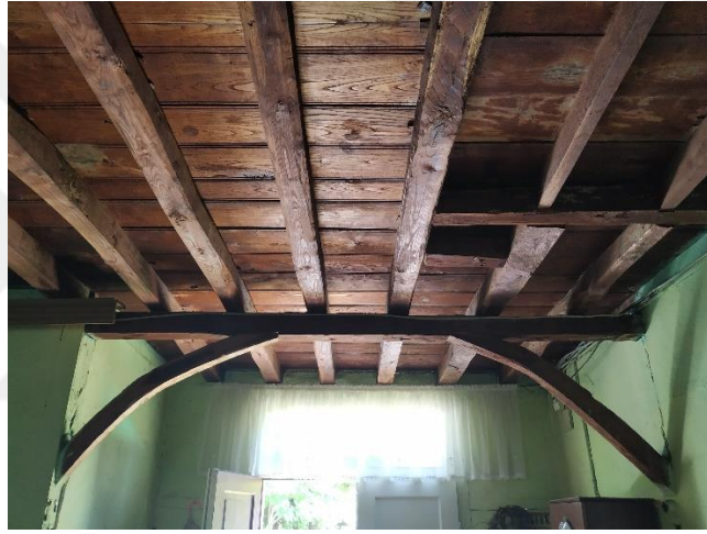
Şekil 3.14 Zemin kat tavan kirişleri
