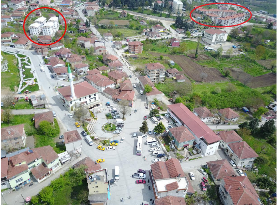
Şekil 5.15 678, 682, 683 ve 3748 parsellerindeki yeni yapılaşma [27]
