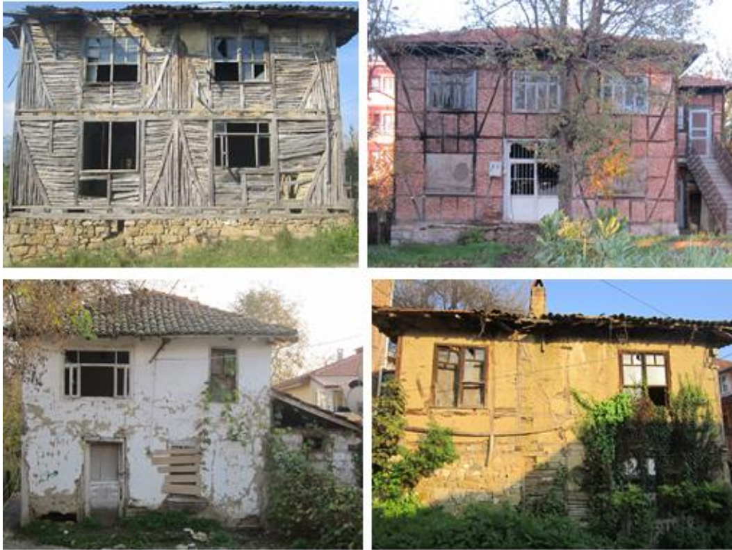
Şekil 4.45 Terk edilmiş yapı örnekleri
