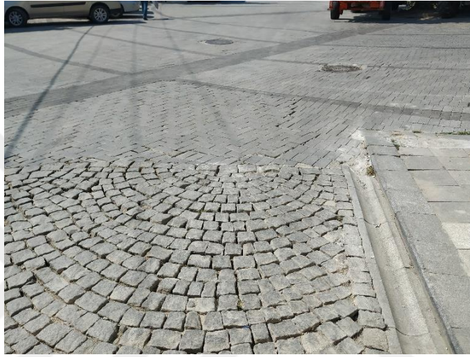
Şekil 4.35 Sokak döşemesi uygulamaları
