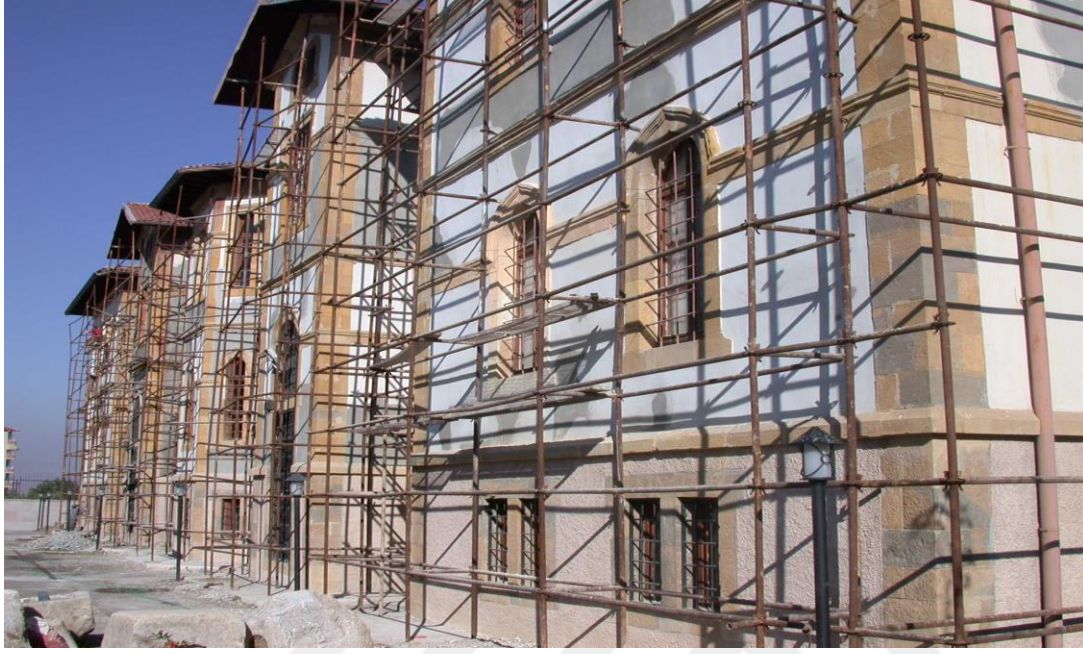
Resim 5. 21. Müze Binası dış cephe onarımı, 2007 (Müze Arşivi)
