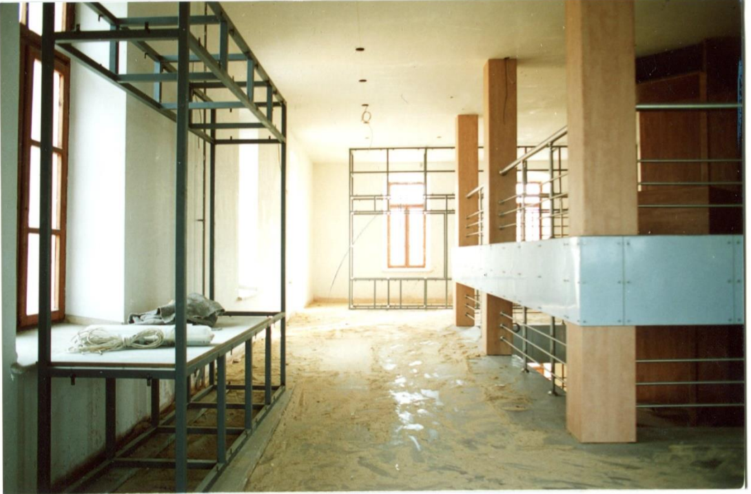
Resim 5.11. Çelik konstrüksiyonla yenilenen iç yapı (Müze Arşivi)
