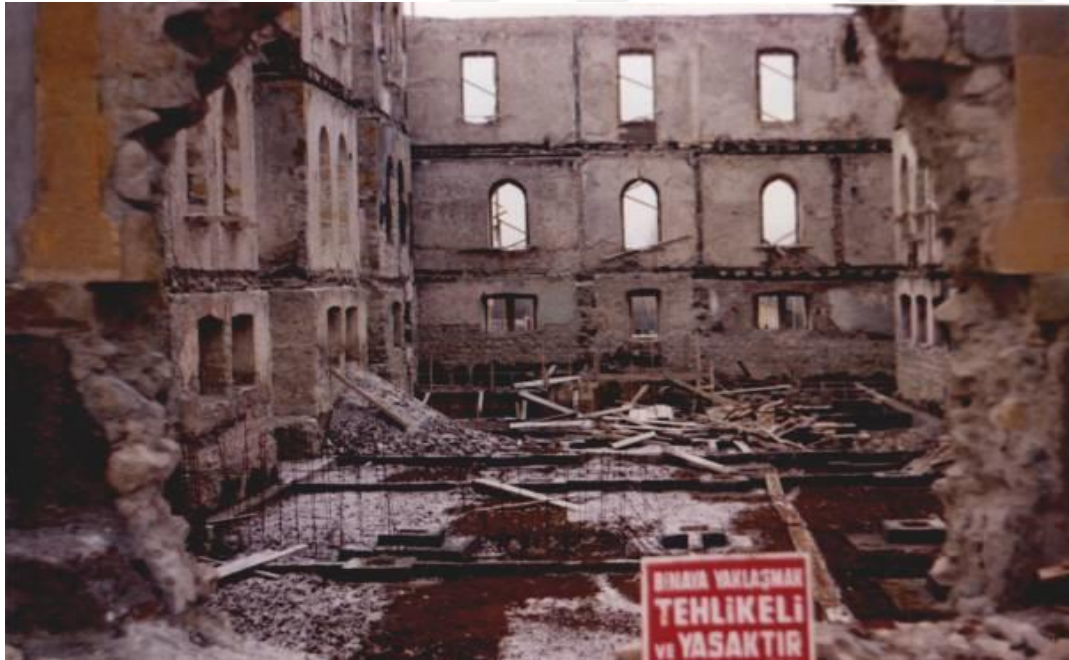
Resim 5.9. Yangın sonrası binanın içinden görünüş (Müze Arşivi)
